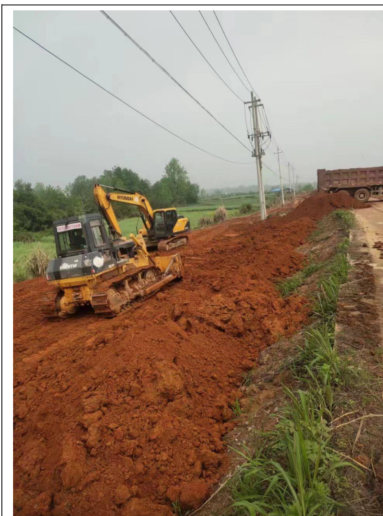
堤防加培土方回填 (2024.03.25)
