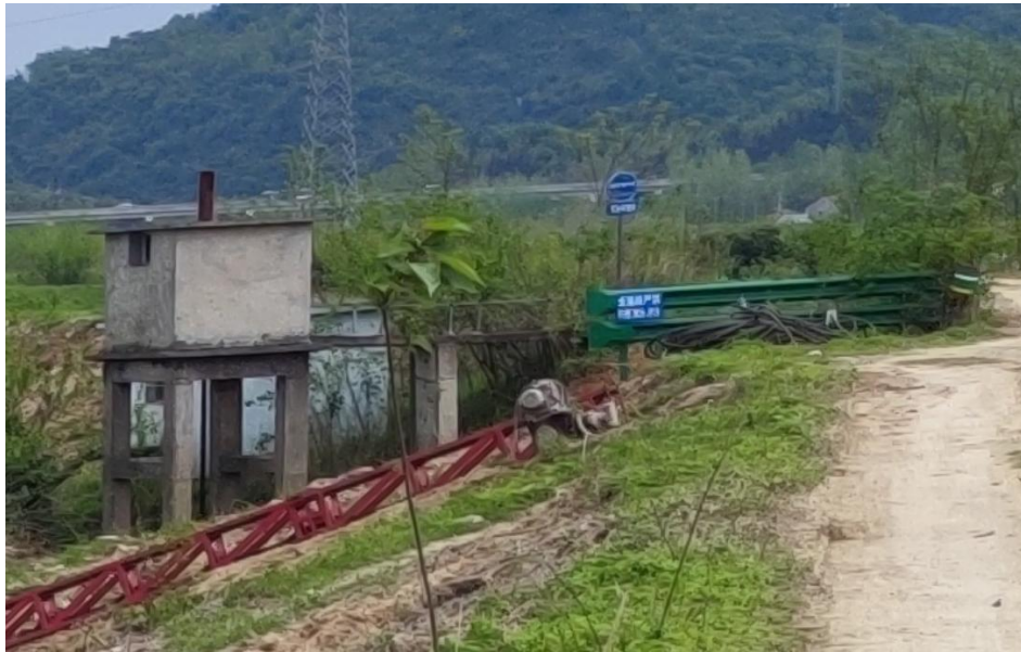
四清下闸原地貌 (2024年3月31日)
