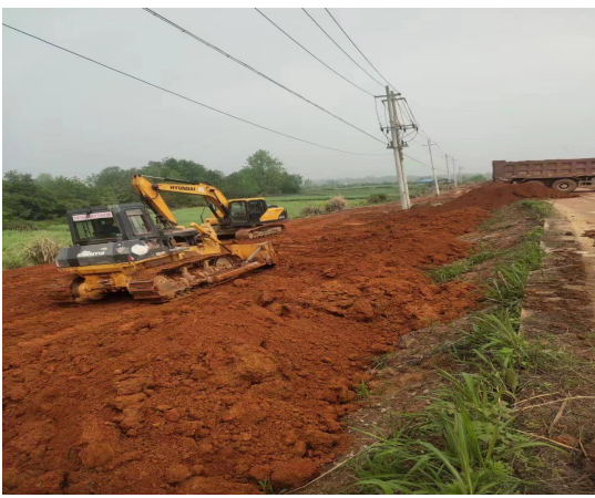
土石方回填碾压
