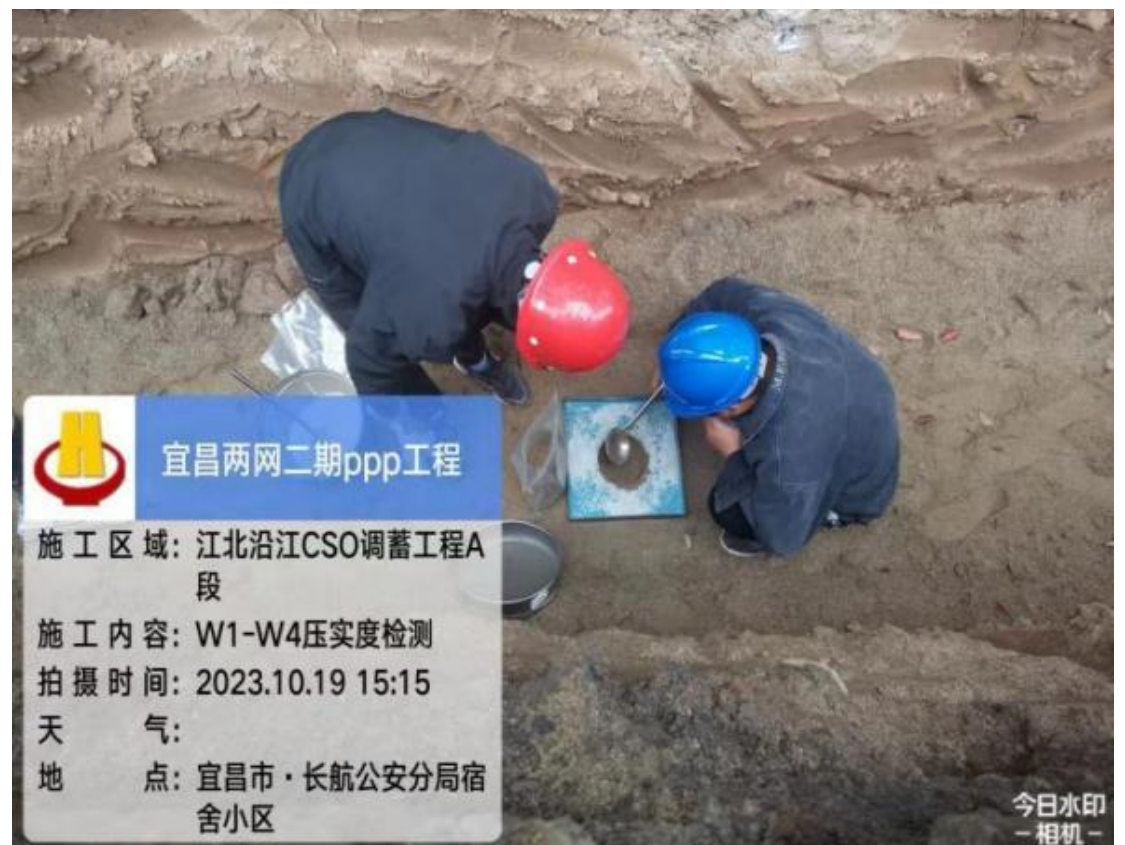
开槽作业区管沟
