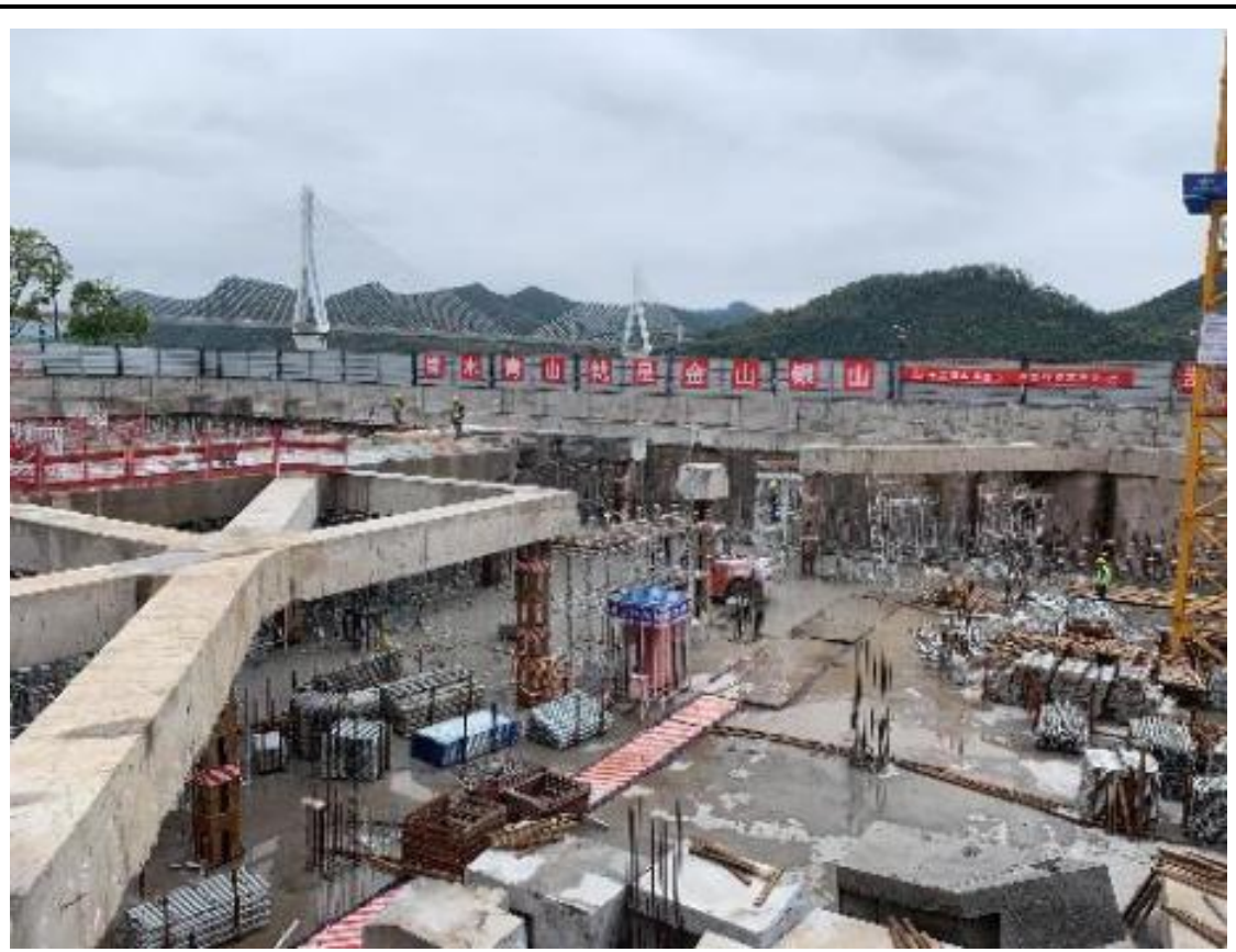
大公桥调蓄池第一道支撑拆除
