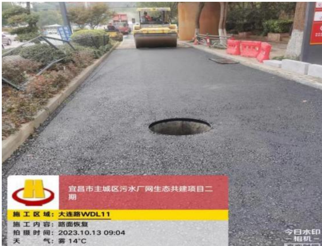
管道工程区路面恢复
