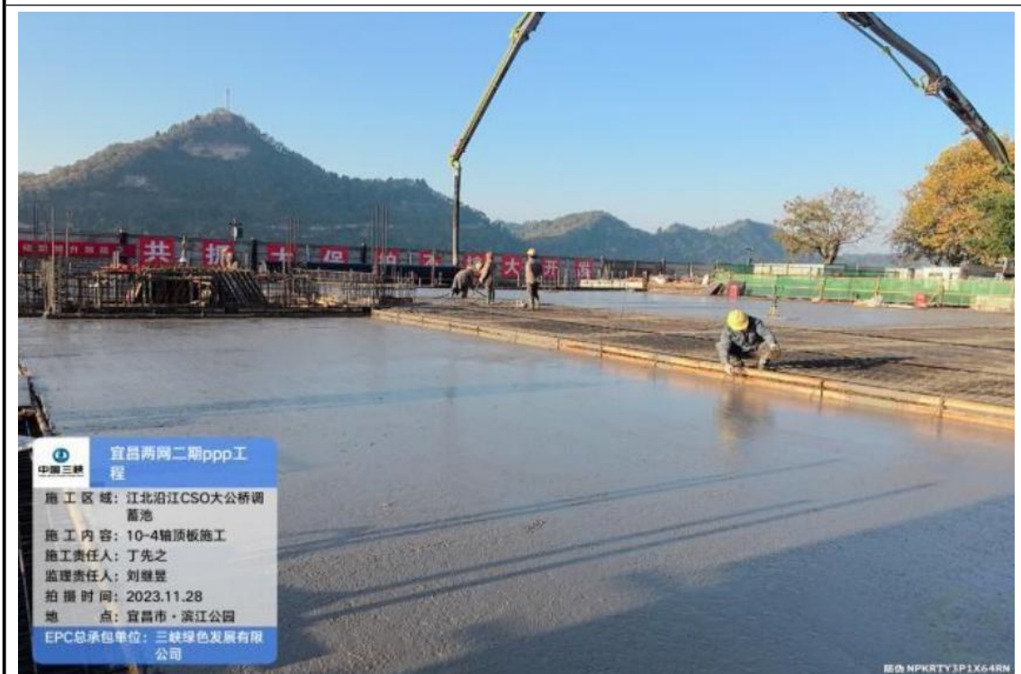
大公桥调蓄池混凝土浇筑
