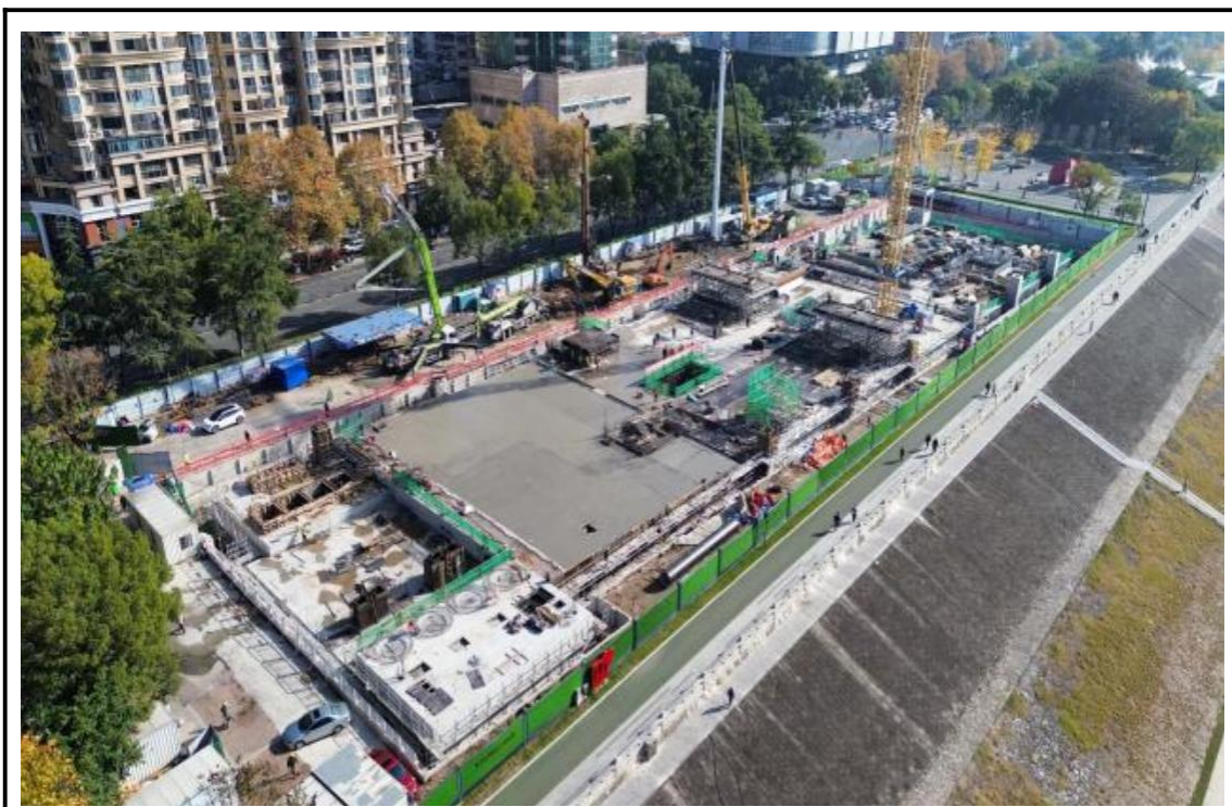
大路桥调蓄池主体结构完工（2023年11月）
