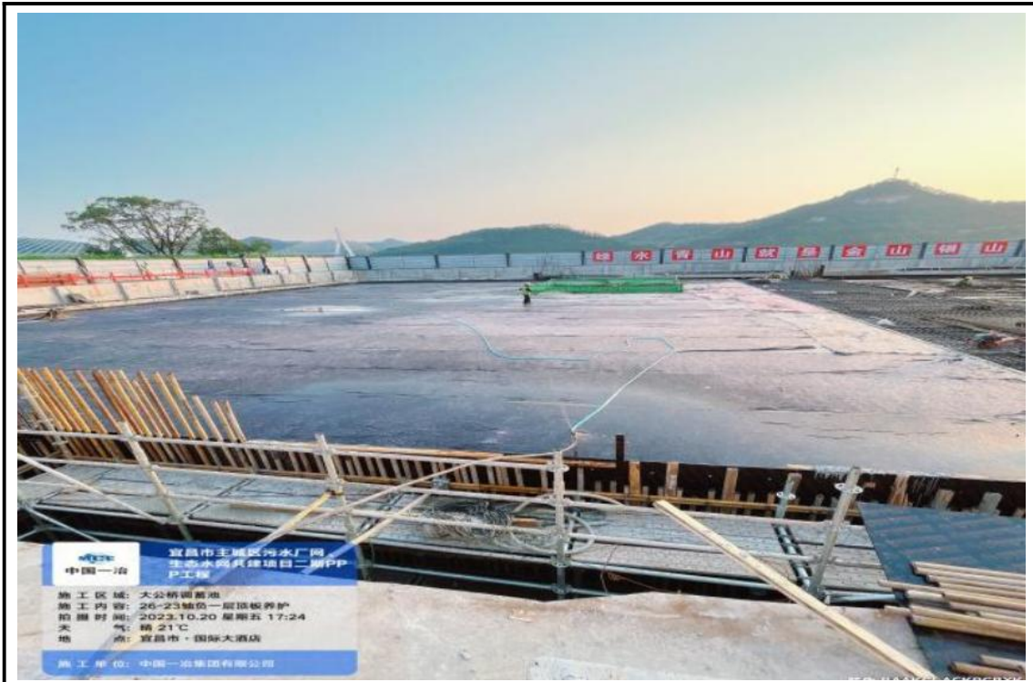
大公桥调蓄池混凝土浇筑
