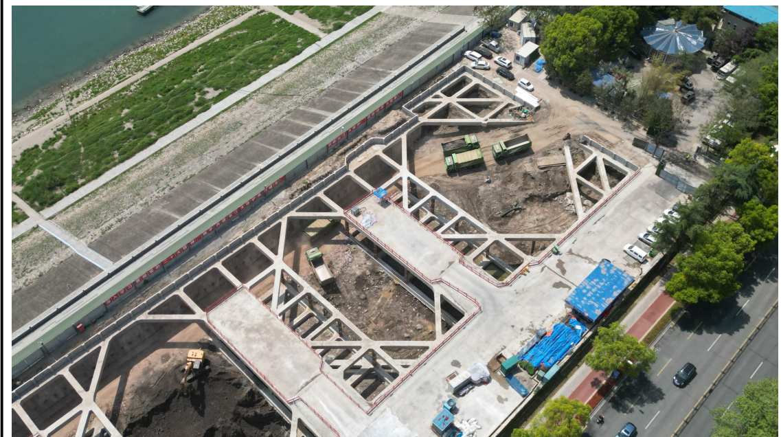
大公桥调蓄池区基坑土方开挖历史影像（2023年3月）
