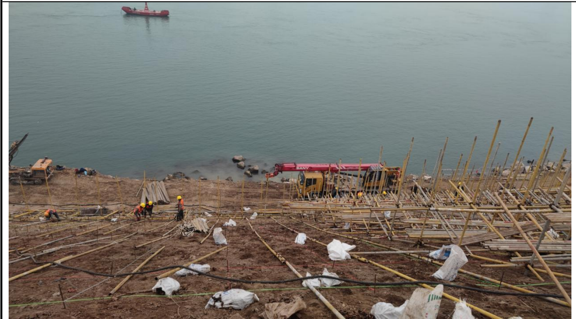
岸坡修整（2023年3月）
