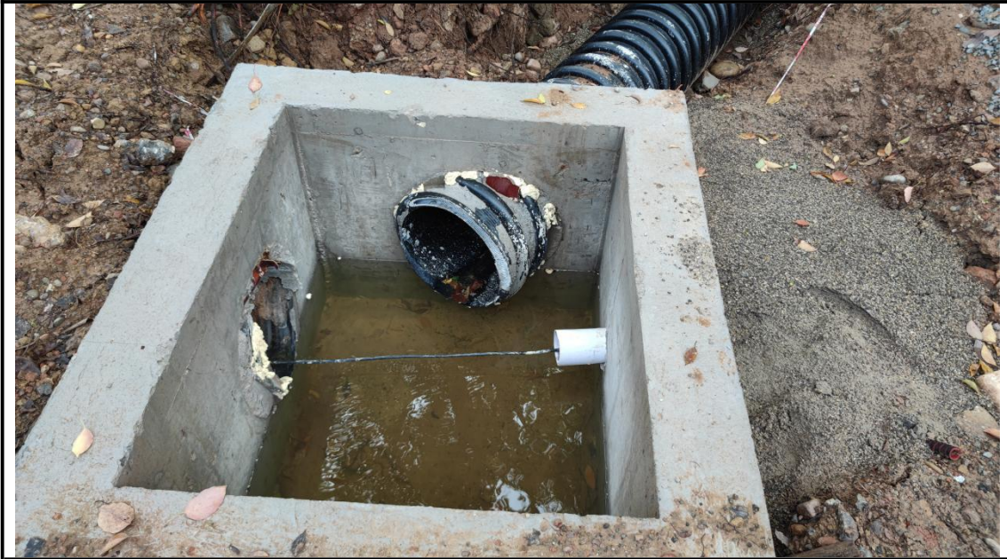
临时沉砂池（2023年3月）
