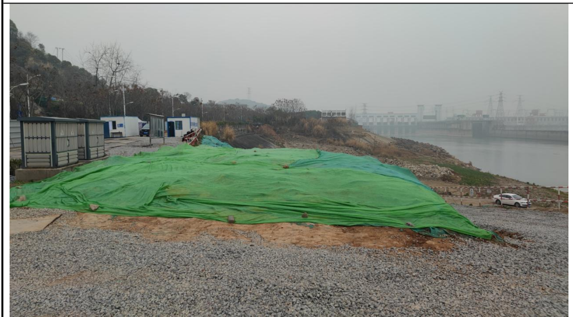
临时苫盖（2023年3月）
