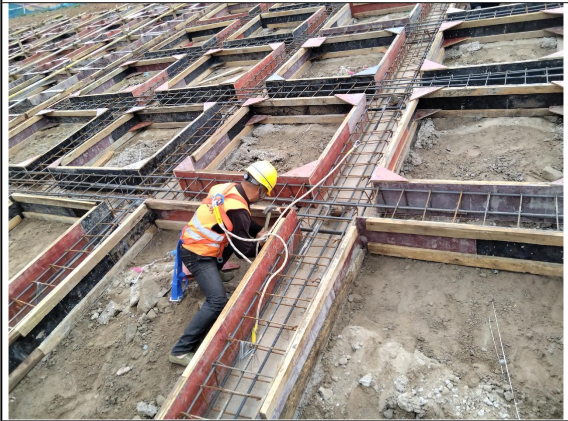
岸坡浇筑（2023年4月）
