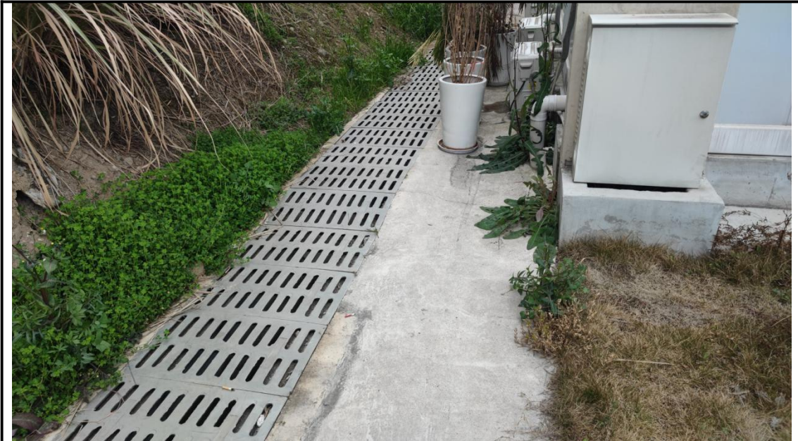
临时排水沟（2023年9月）
