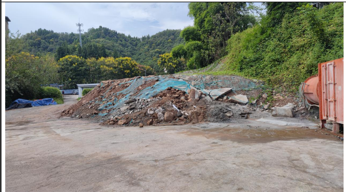
临时苫盖（2023年9月）
