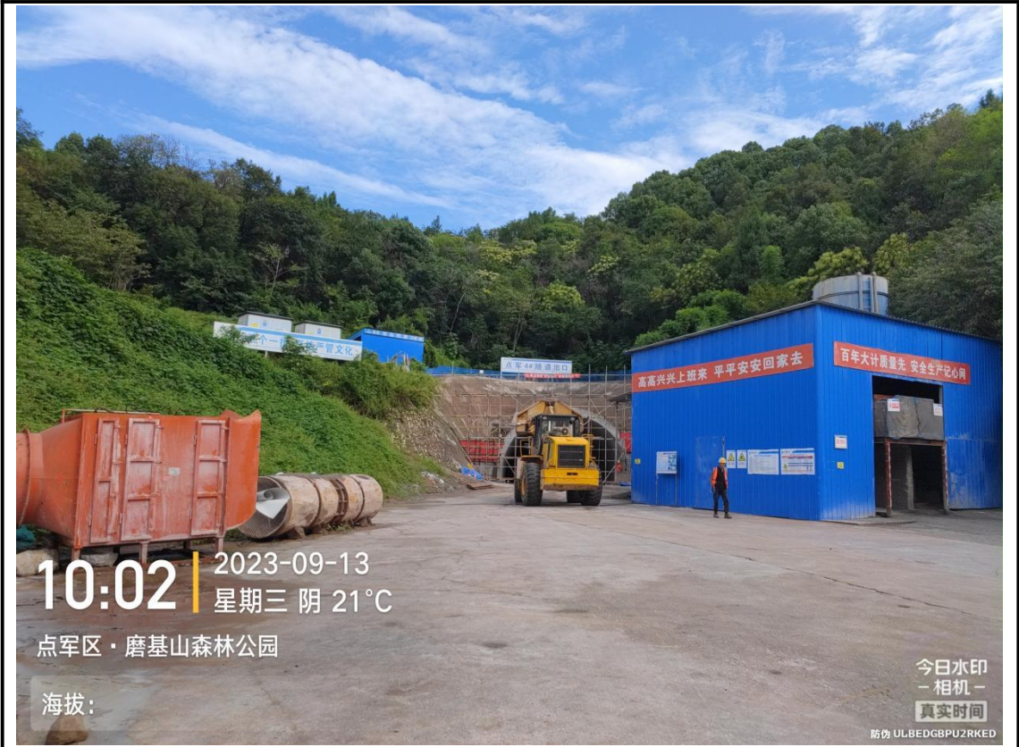
施工场地（2023年9月）
