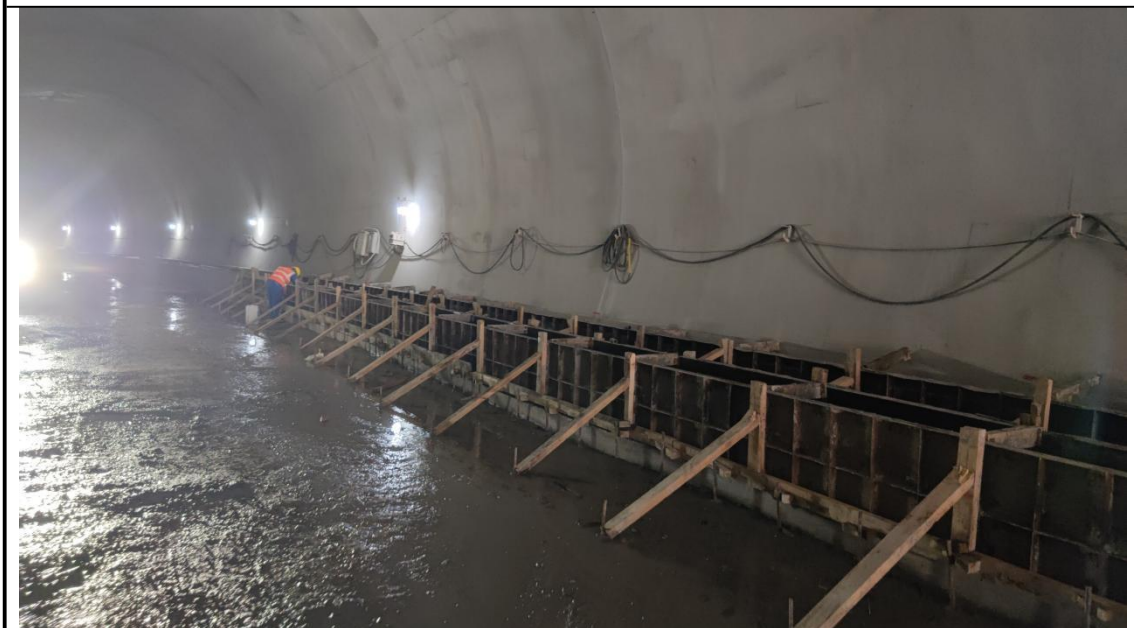
铺设混凝土垫层（2023年11月）
