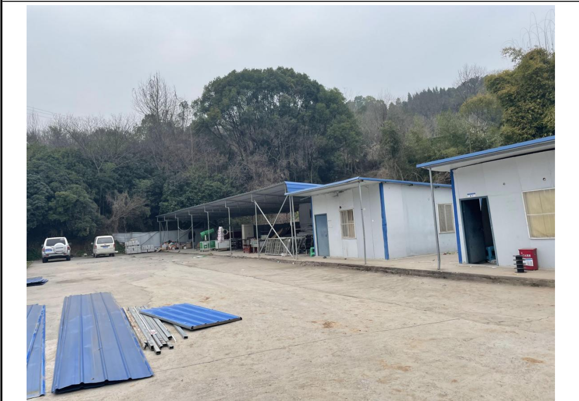
施工场地 (2024年3月)
