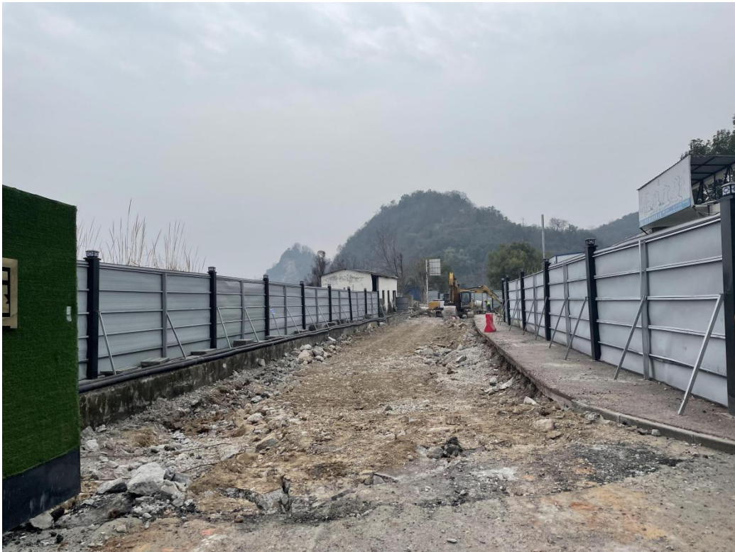
路面破除 (2024 年 3 月)
