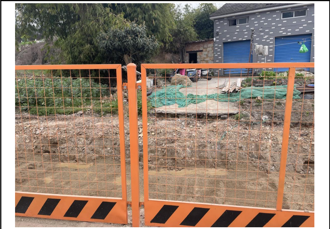
管道开挖 (2024 年 3 月)
