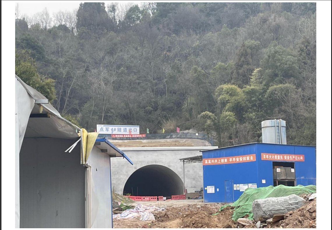
隧道工程 (2024 年 3 月)
