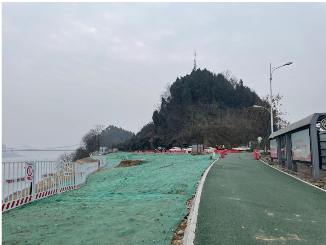
临时苫盖 (2024 年 3 月)
