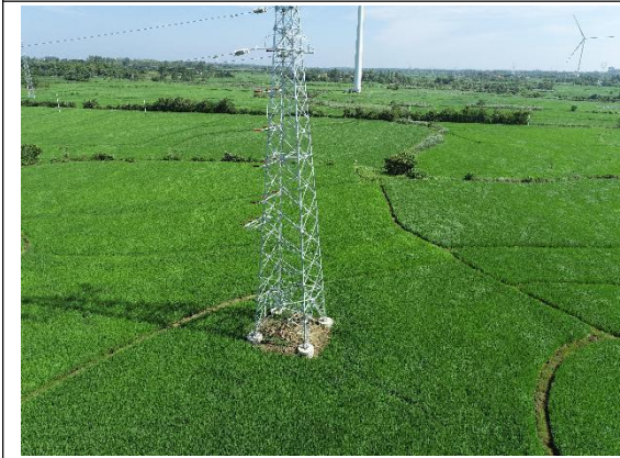
集电线路塔基
