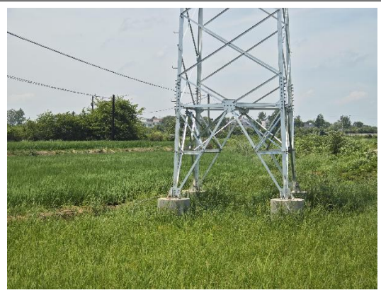
集电线路塔基
