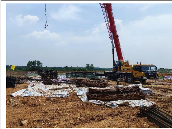
Z07 风机基础施工 (2024.5.07)
