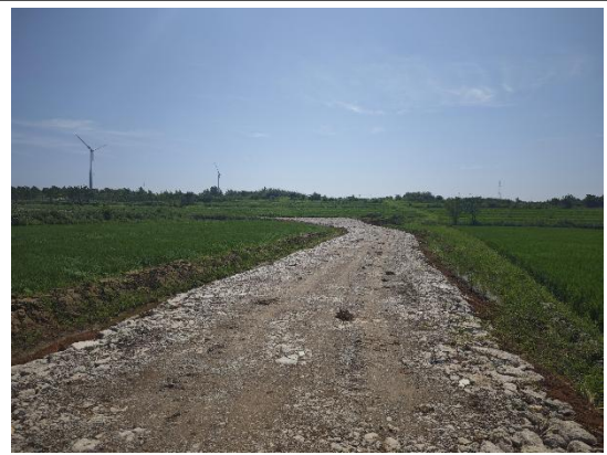
道路石渣铺设 (2024.6.28)
