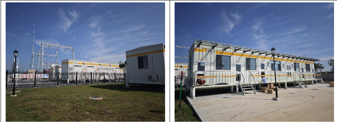
升压站及储能电站
