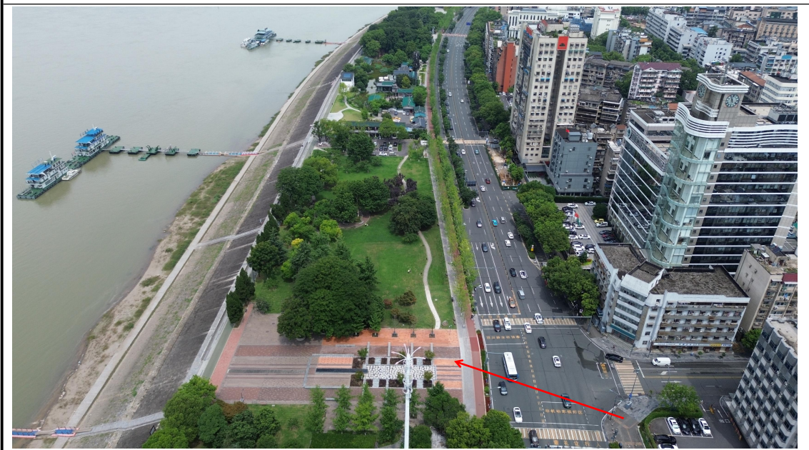
顶管作业区已恢复（2024年6月）
