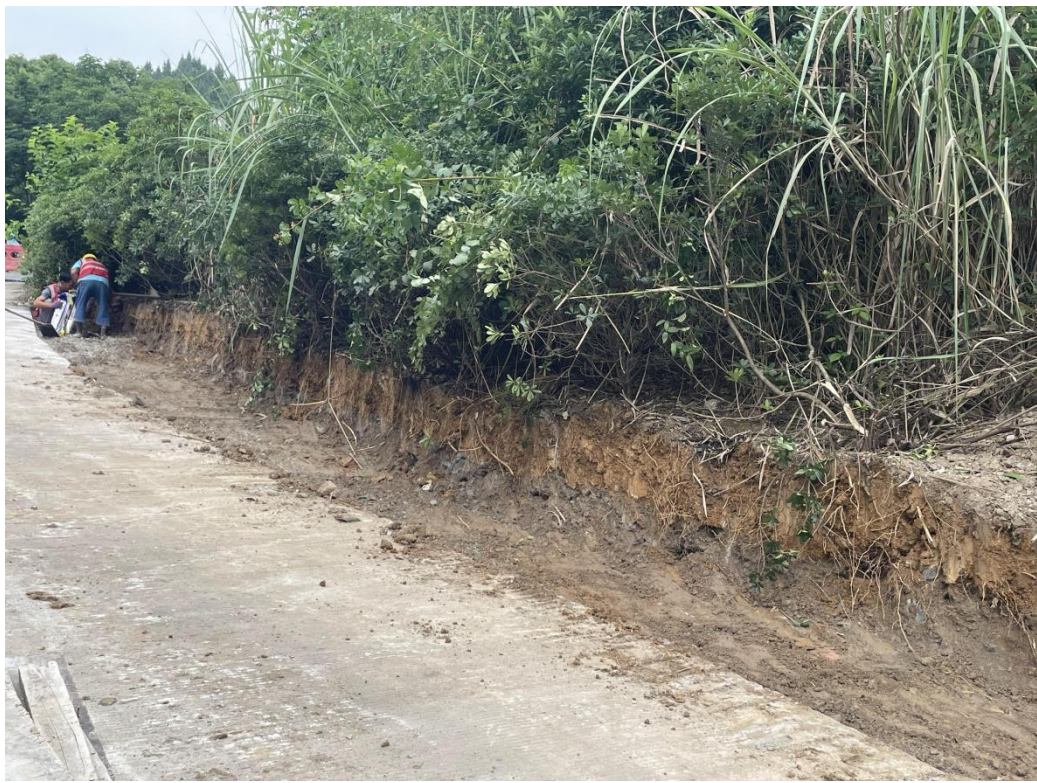
管道工程（2024年6月）
