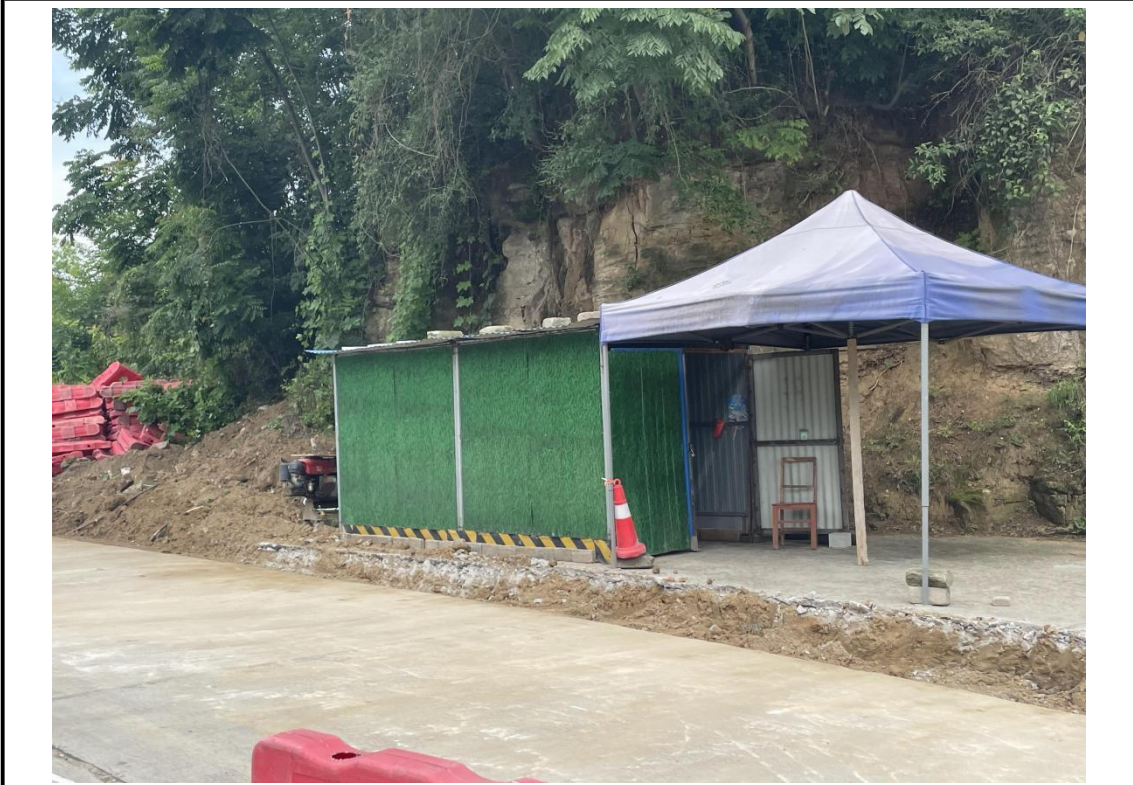
施工场地（2024年6月）
