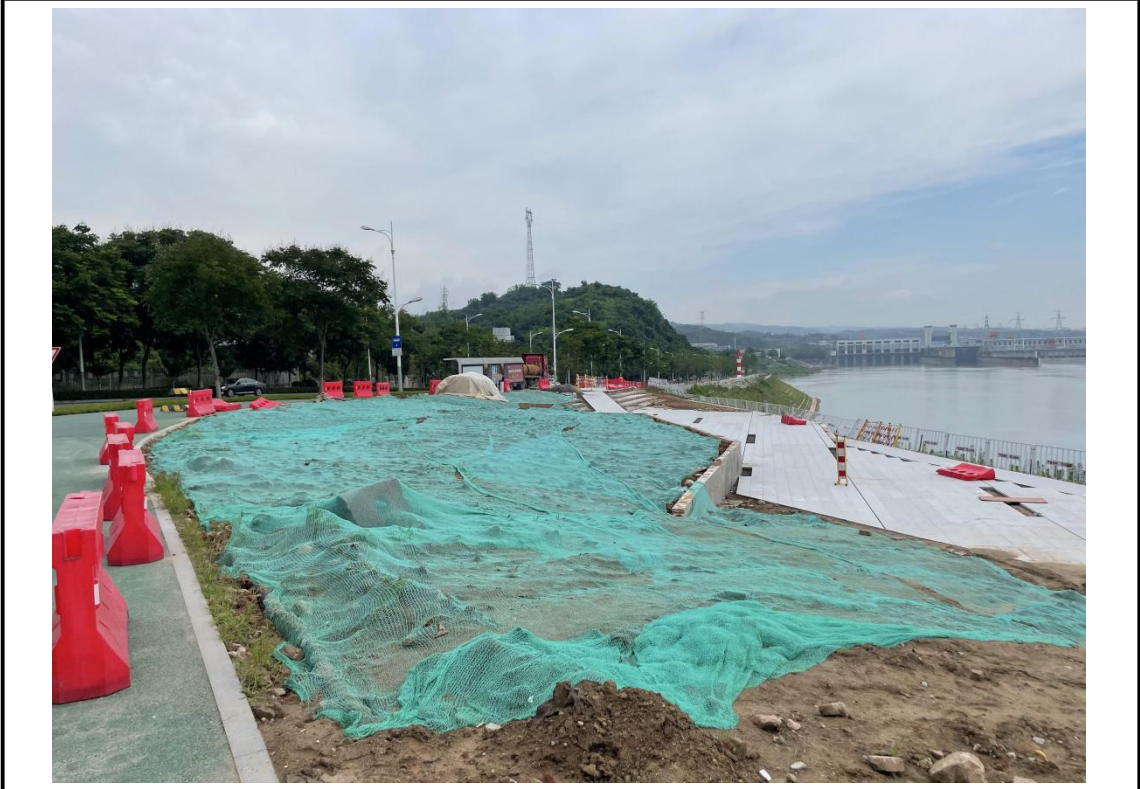
临时苫盖（2024年6月）
