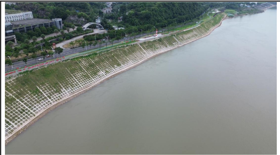
岸坡治理（2024年6月）
