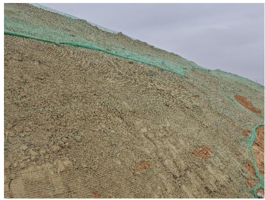
临时堆土苫盖 (2024.9.30)
