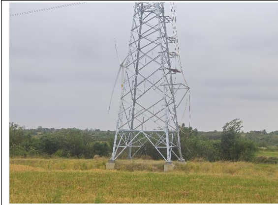
集电线路塔基
