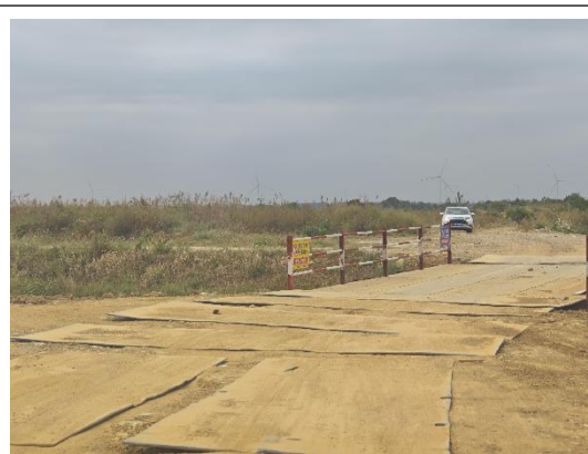
Z05 道路钢板铺设
