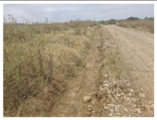
道路土质排水沟
