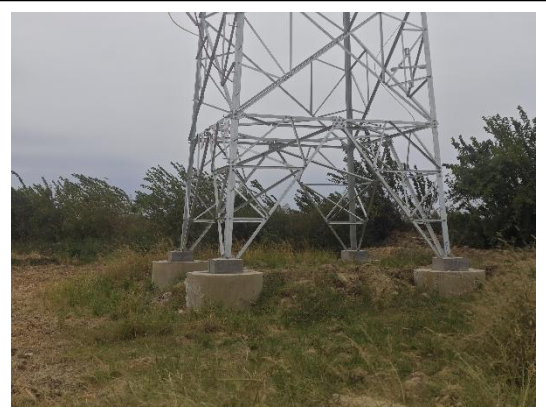
集电线路塔基
