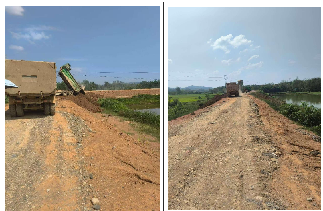
堤防加培土方回填 (2024.09.10)
