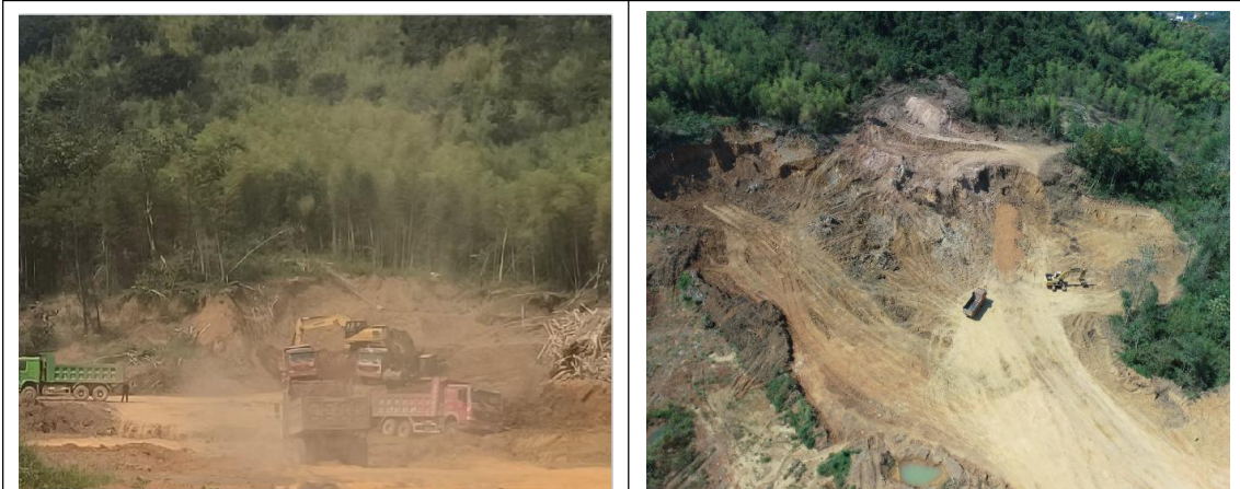
取土场土石方开挖运输 (2024.09.09)
