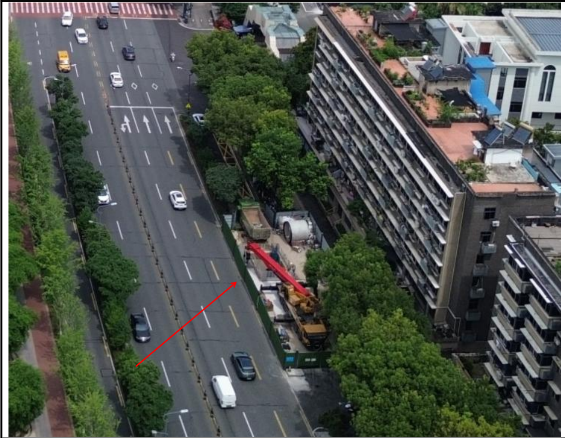
顶管作业区（2024年6月）
