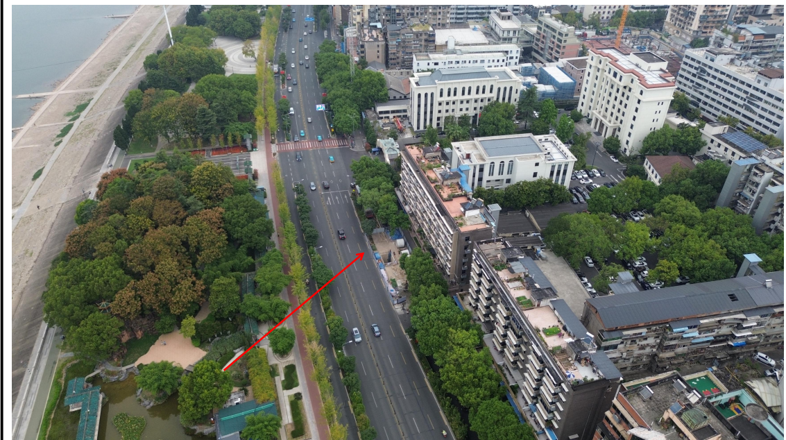
顶管作业区（2024年9月）
