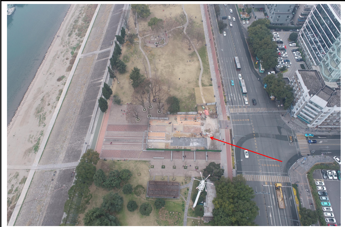
顶管作业区（2024年3月）
