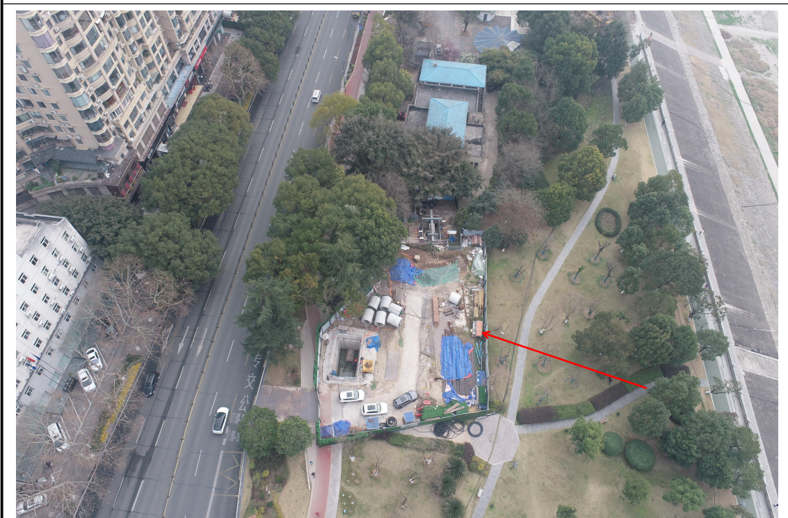
顶管作业区（2024年3月）
