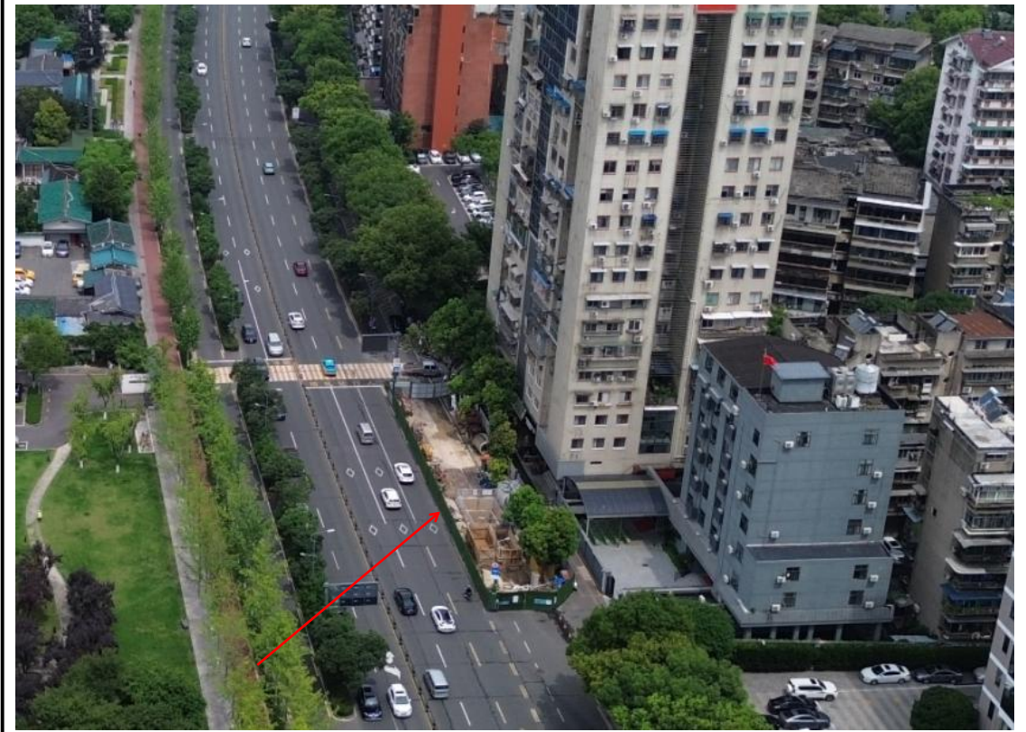
顶管作业区（2024年3月）
