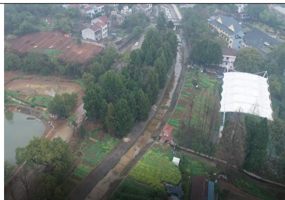
北千渠 0+200~0+300 局部现状
