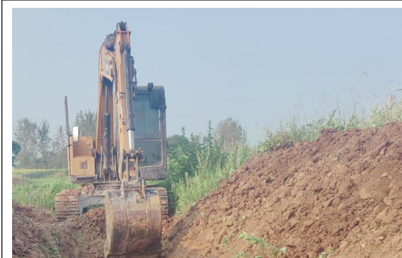
文魏支渠渠底坡面开挖
