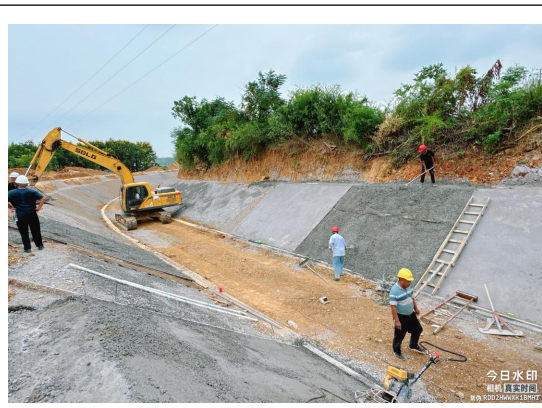
混凝土浇筑施工 (2024.9.11)
