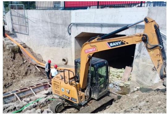
北干渠围堰填筑
