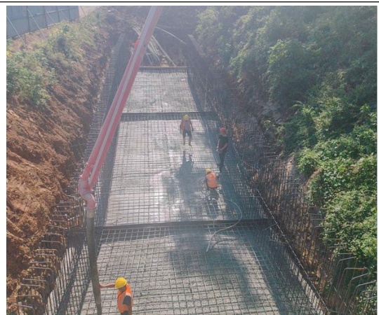
矩形渠混凝土浇筑
