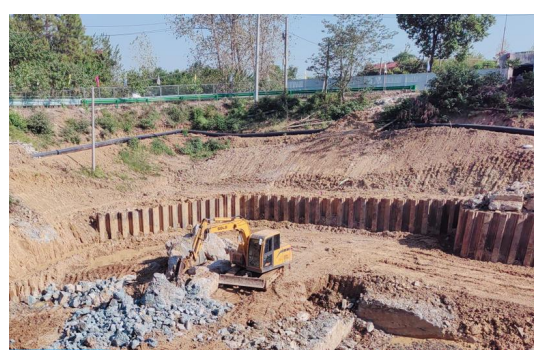
刘庙泵站施工
