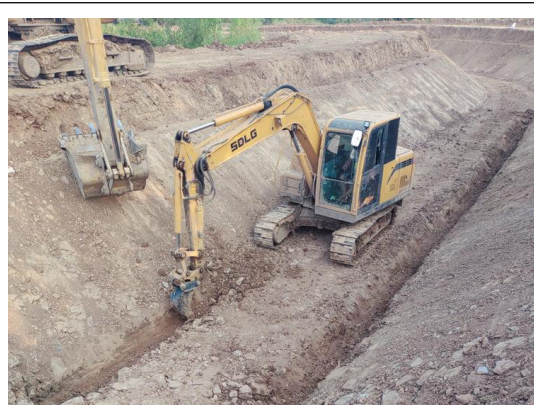
南干渠底脚槽施工
