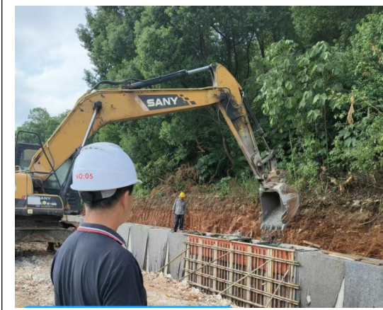
俯斜式挡墙浇筑 (2024.9.16)
