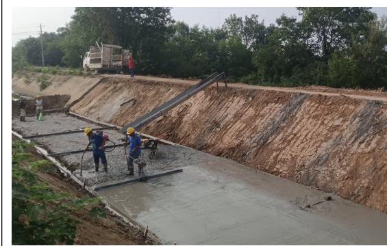
北干渠渠底浇筑
