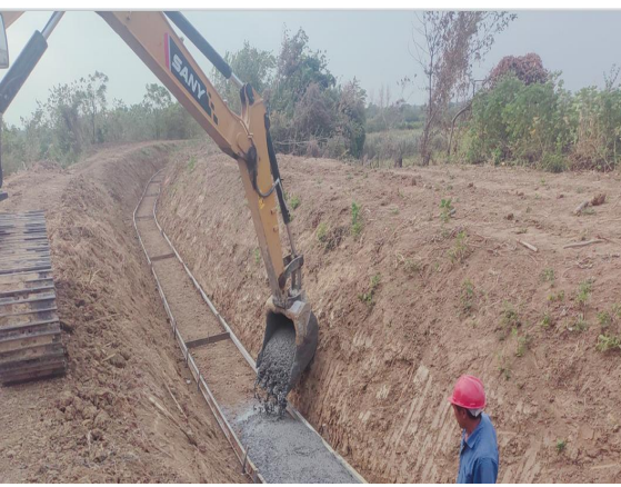
支渠底板混凝土浇筑 (2024.9.30)
