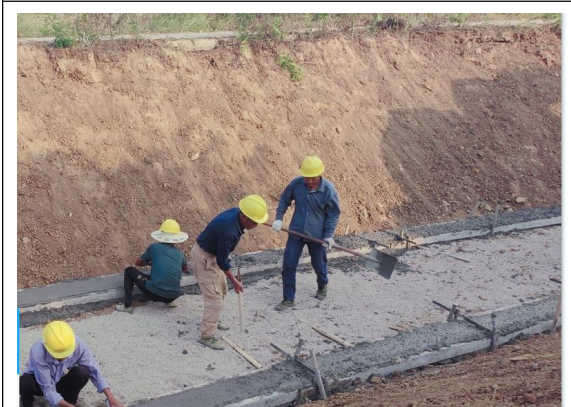
南干渠脚槽混凝土浇筑
