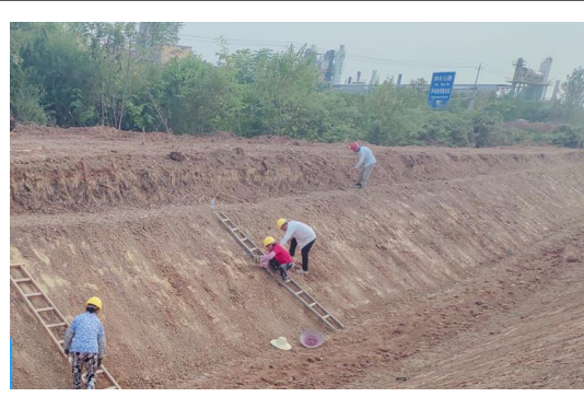
南干渠坡面整治
