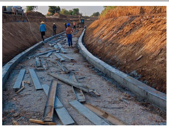
北干渠护坡模板安装
