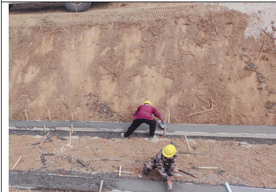
脚槽混凝土浇筑 (2024.09.20)
