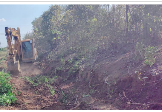
底板坡面开挖整形 (2024.09.29)
