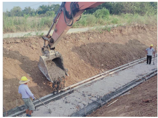
南干渠脚槽混凝土浇筑
