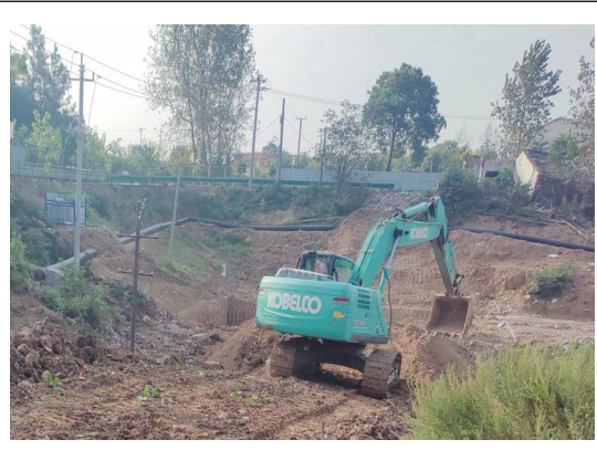
刘庙泵站修建施工便道
