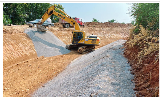
边坡粗砂铺设
