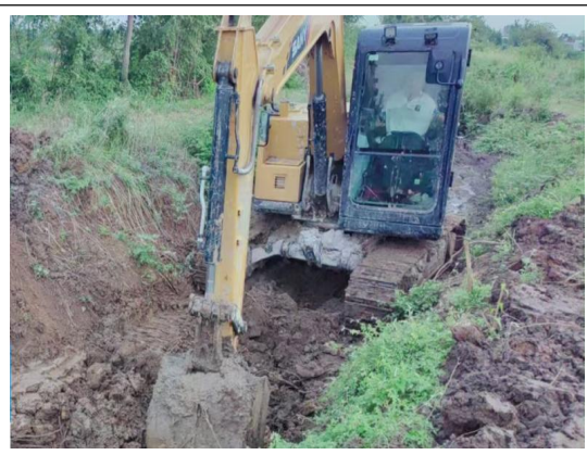
渠底坡面开挖
