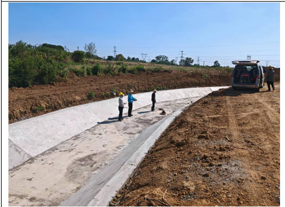
北干渠混凝土护坡
