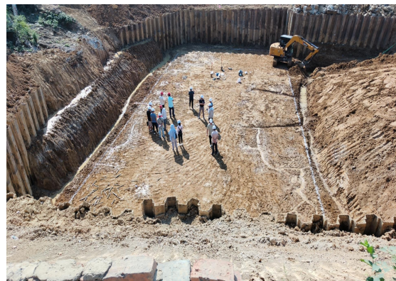
基坑临时排水沟 (2024.9.23)
