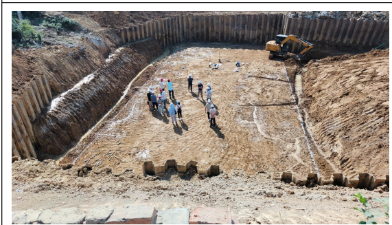
泵站基础开挖
