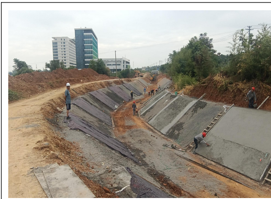
混凝土浇筑施工 (2024.9.30)
