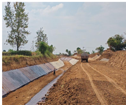
北干渠坡面洒水养护
