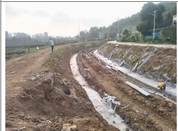
脚槽混凝土浇筑
