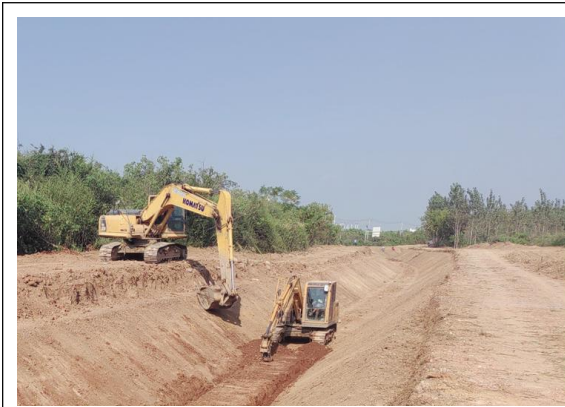
南干渠底脚槽施工
