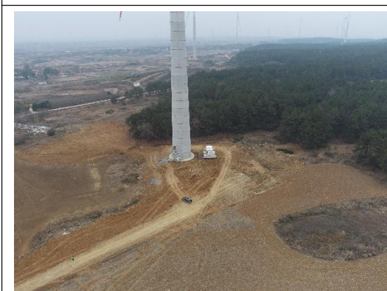
Z05 风机吊装平台 (2024.12.25)
