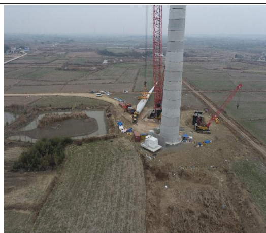
Z09 风机吊装
