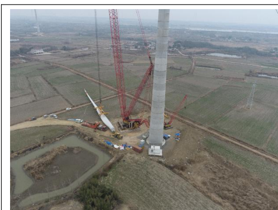
Z09 风机吊装平台 (2024.12.25)
