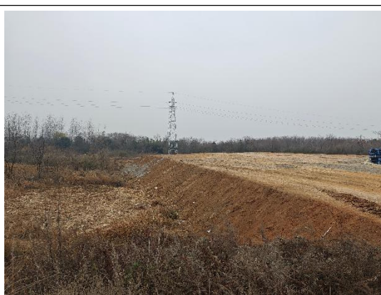
Z18 风机平台边坡整治 (2024.12.25)
