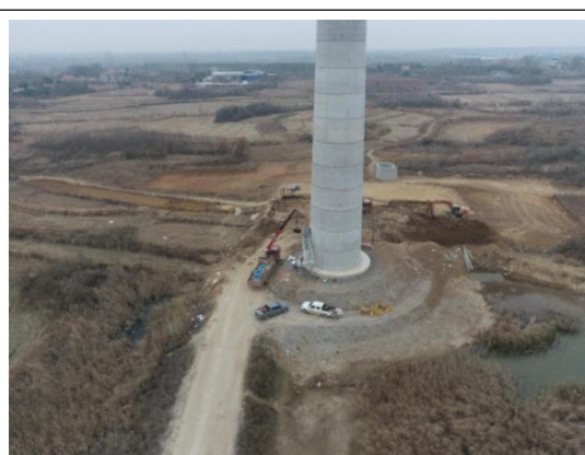
Z17 风机吊装平台 (2024.12.25)
