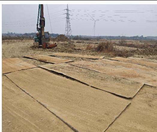
Z10 钢板铺设
