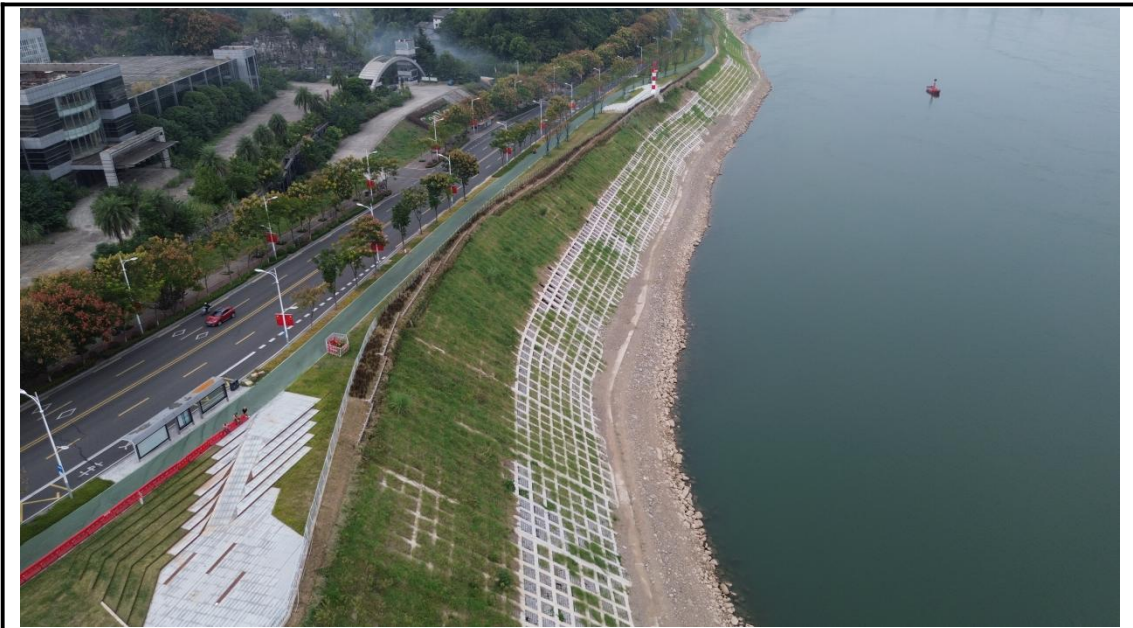
岸坡治理（2024年9月）
