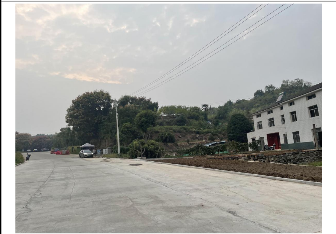
施工场地（2024年9月）
