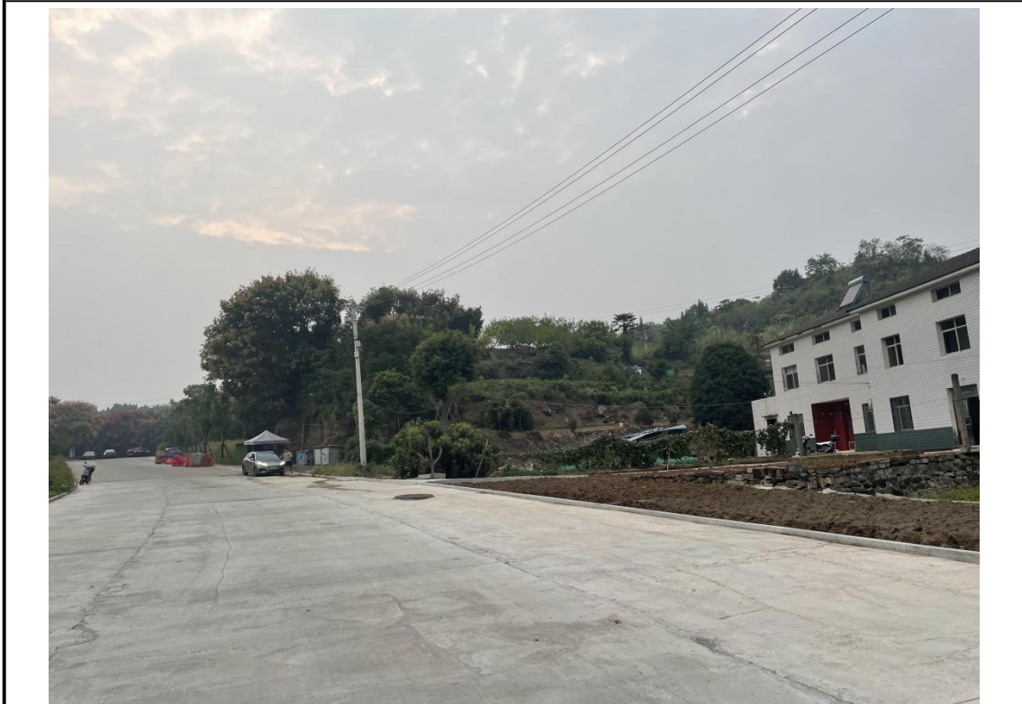
施工场地（2024年12月）
