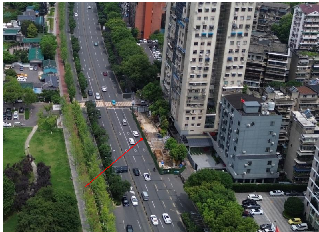
顶管作业区（2024年6月）
