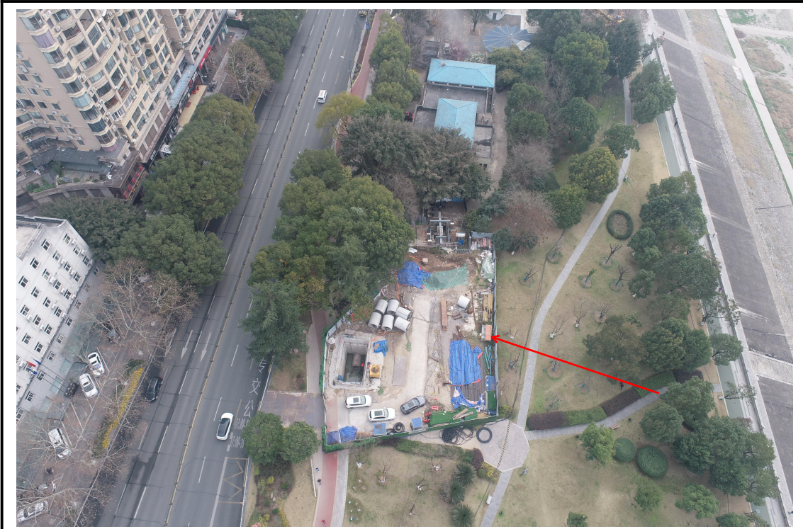
顶管作业区（2024年3月）
