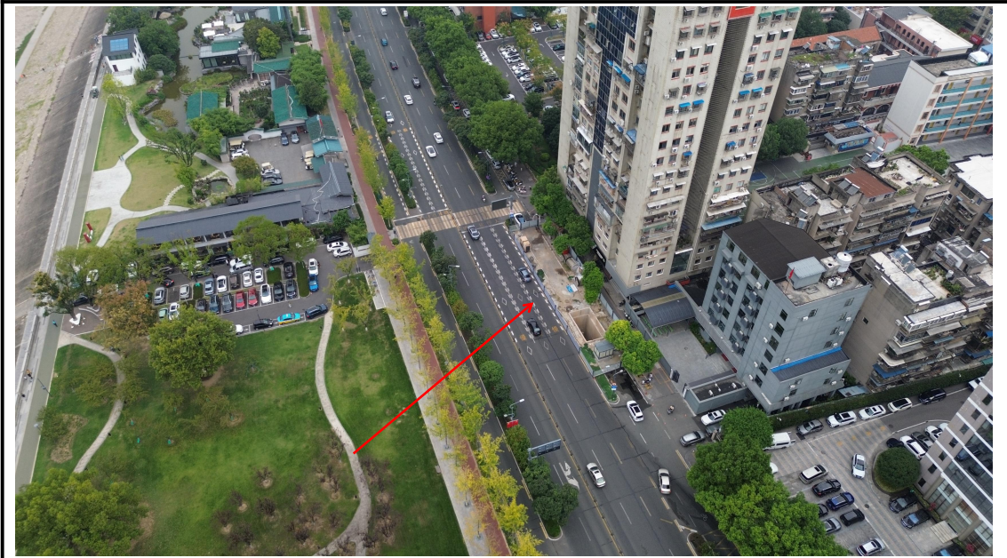
顶管作业区（2024年9月）
