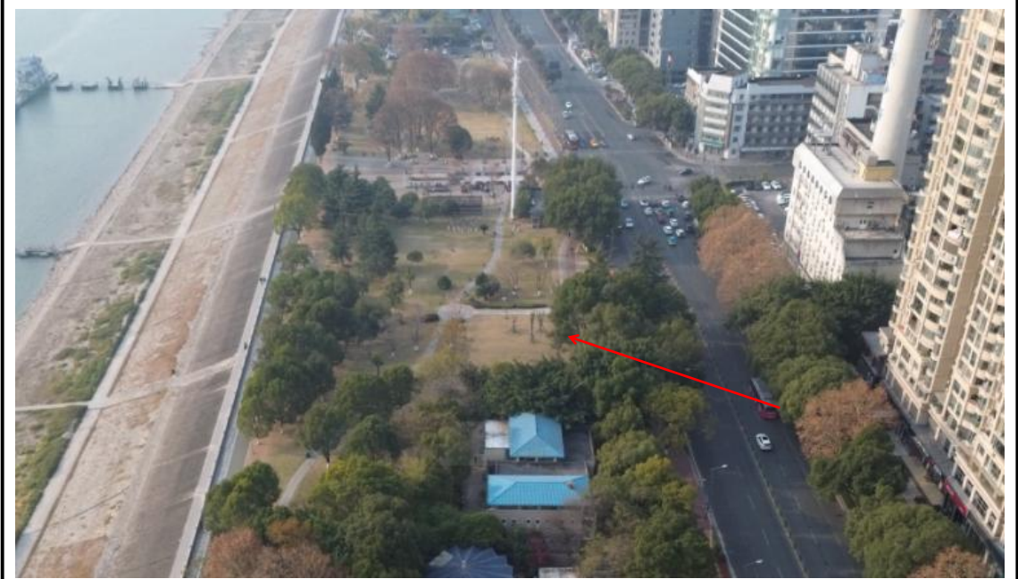
顶管作业区已恢复（2024年12月）
