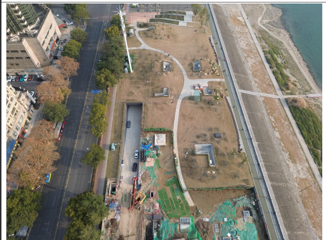
站场工程区（大公桥调蓄池）（2024年12月）
