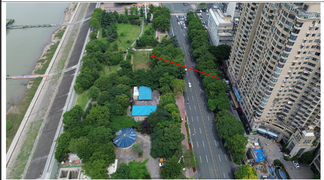
顶管作业区已恢复（2024年6月）
