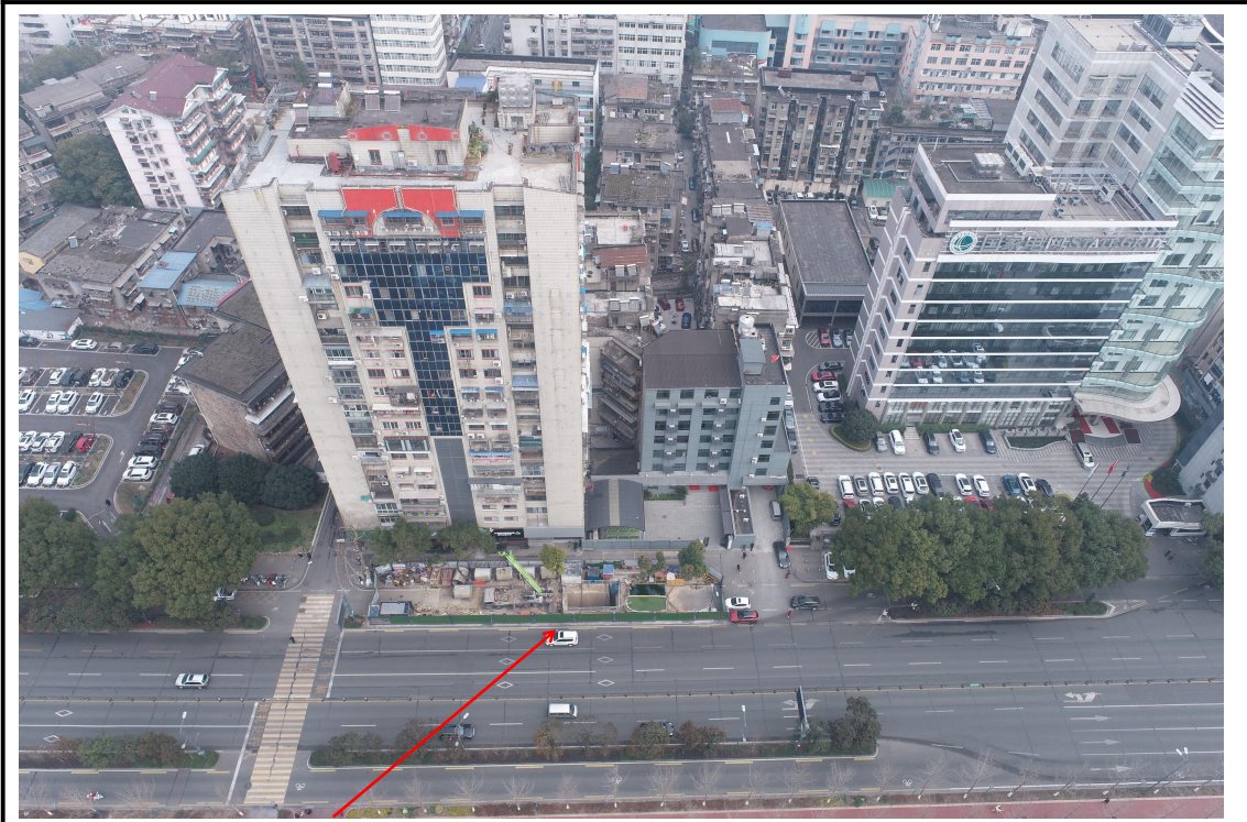
顶管作业区（2024年3月）
