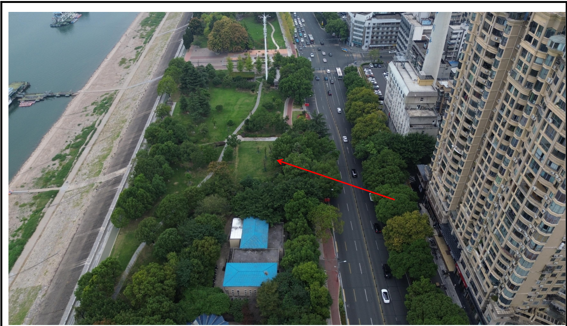
顶管作业区已恢复（2024年9月）
