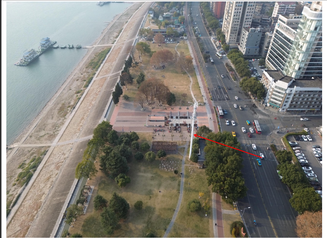
顶管作业区已恢复（2024年12月）
