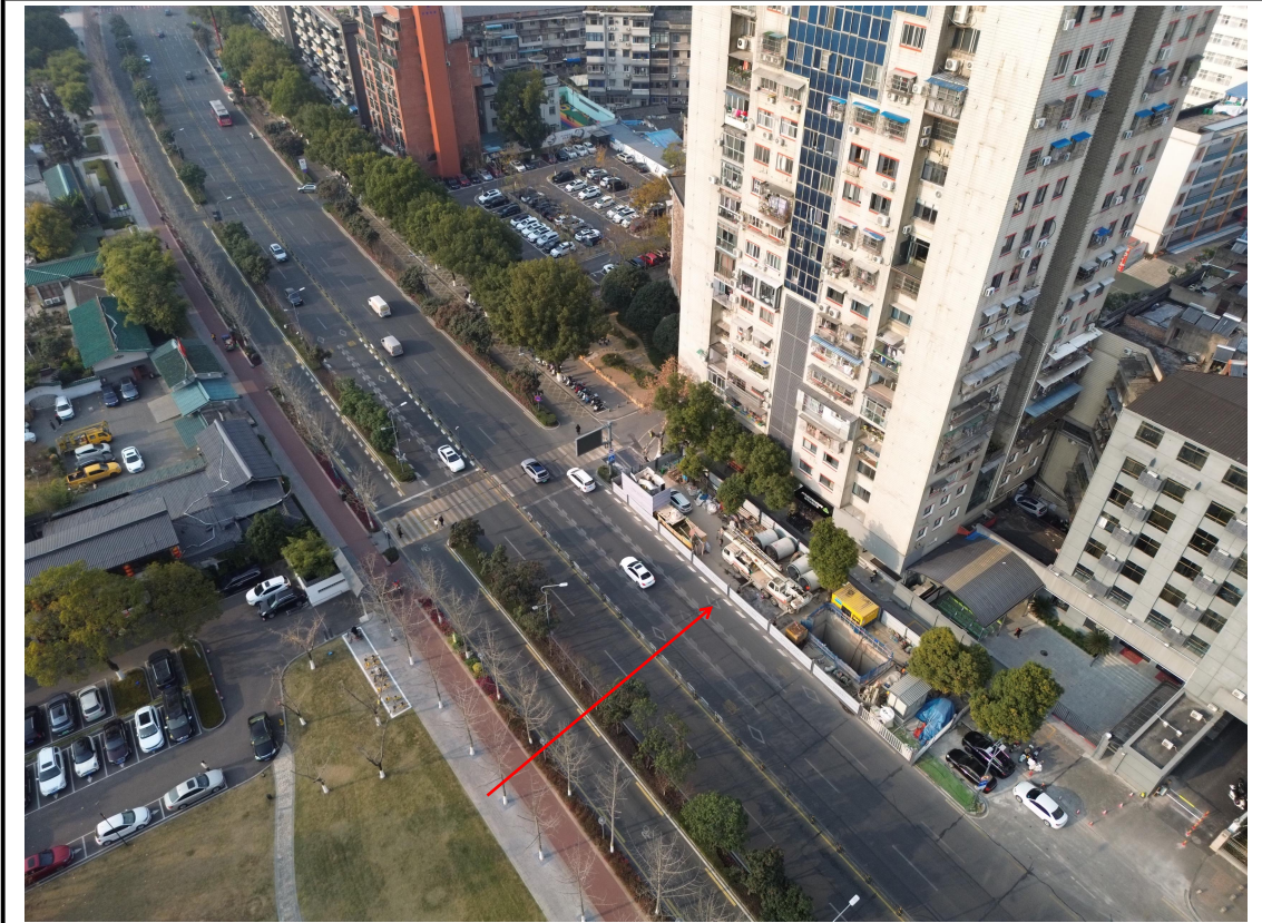
顶管作业区（2024年12月）
