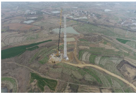
Z15 风机吊装平台 (2025.3.11)
