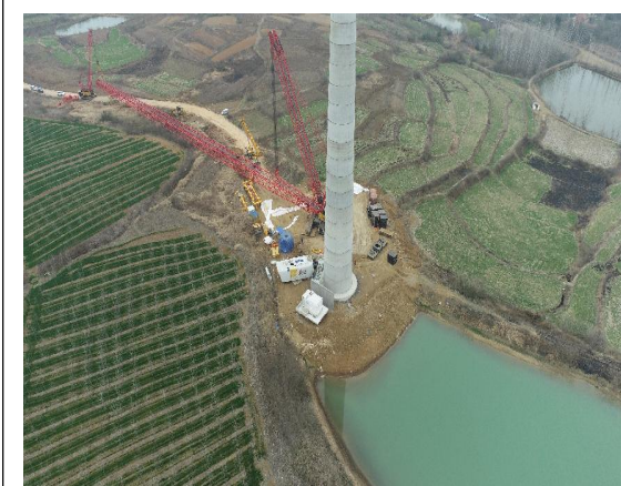
Z12 风机吊装
