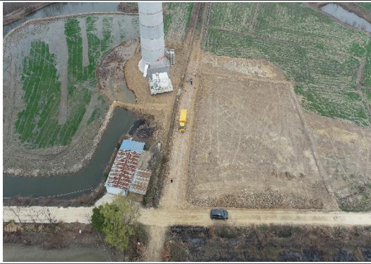
Z08 风机平台恢复情况 (2025.3.11)
