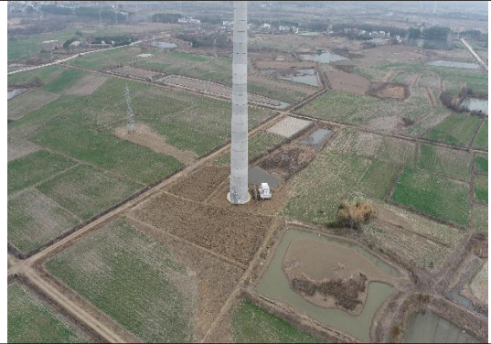
Z09 风机平台恢复情况 (2025.3.11)
