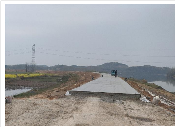
四清段堤顶道路浇筑 (2025.3.18)
