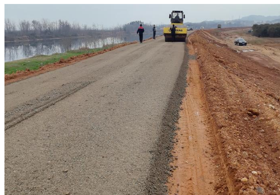
四清段堤顶道路水稳垫层 (2025.3.11)
