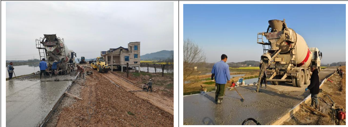
混凝土浇筑
