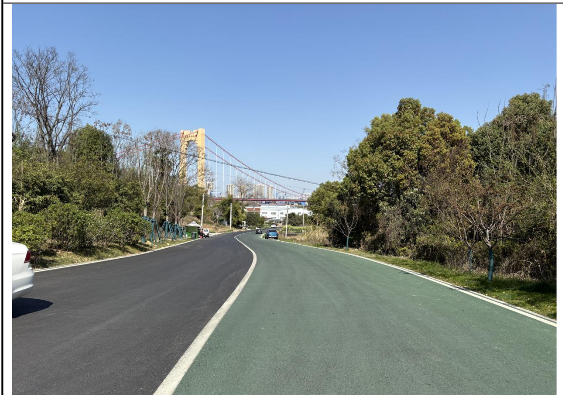
施工场地恢复（2025年3月）
