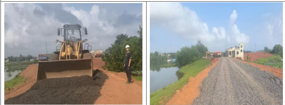
盘石堤顶碎石铺筑
