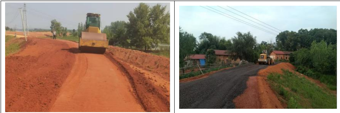
堤顶道路碾压
