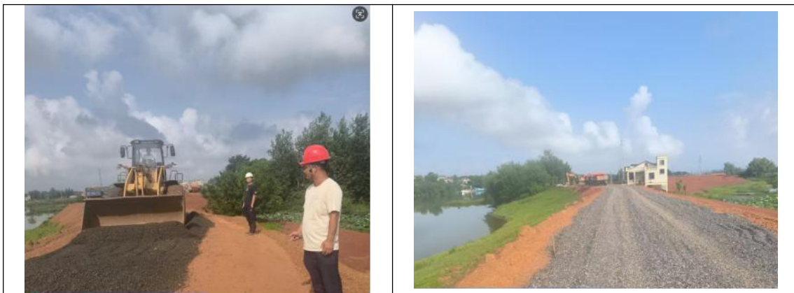
盘石段堤顶碎石铺筑（2025.6.24）
