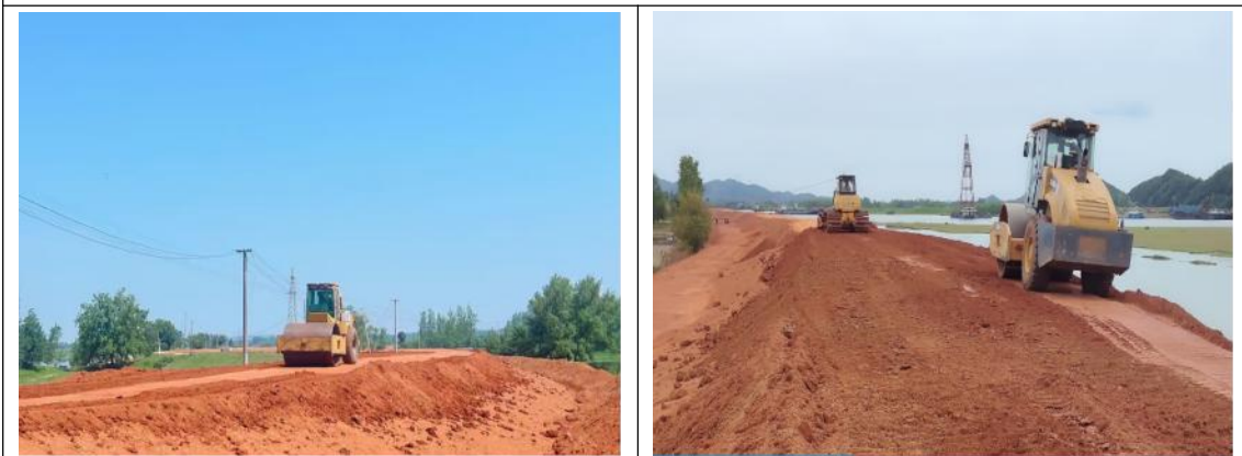
盘石垸土方施工
