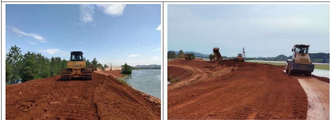
盘石段堤顶回填碾压（2025.6.24）
