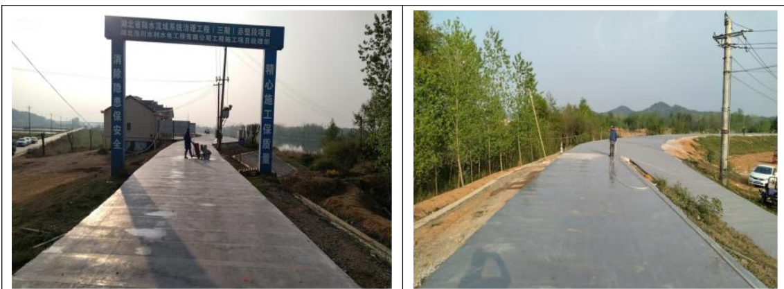
堤顶道路养护
