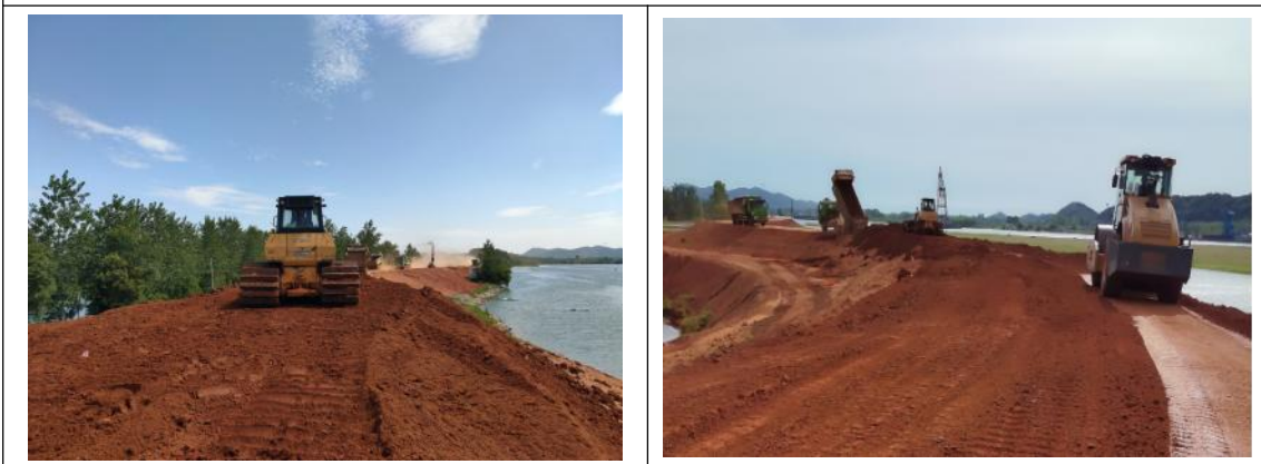
盘石垸土方施工
