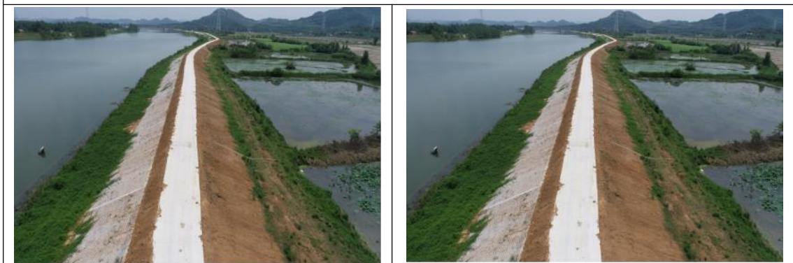
四清段堤顶路面硬化（2025.6.9）
