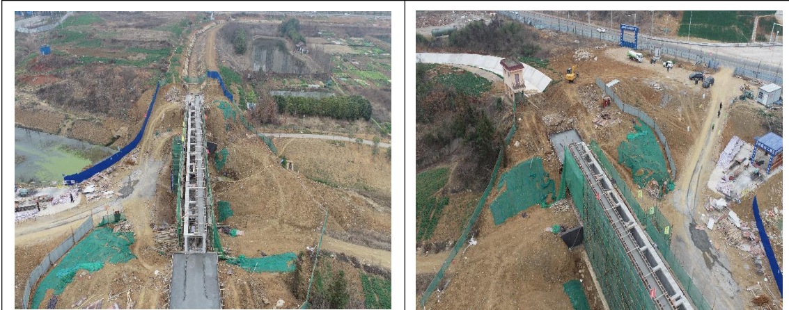
窖山渡槽施工 (2025.2.19)
