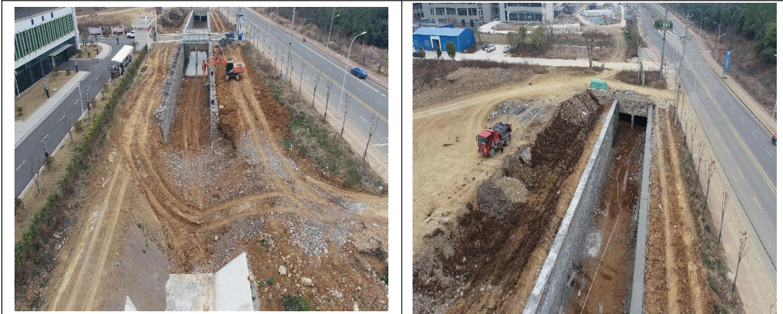
渠道浆砌石挡土墙施工 (2025.2.19)
