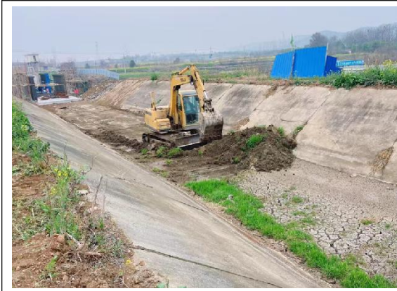
渠道清淤开挖 (2025.3.15)
