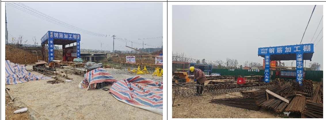
施工场地 (钢筋加工棚) (2025.2.19)
