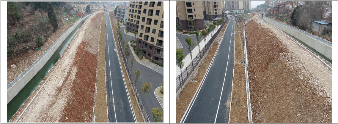
渠道坡面整治（2025.2.19）
