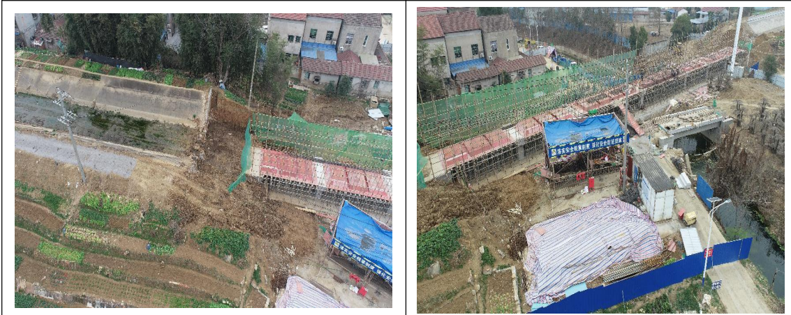
乌龙垵渡槽施工 (2025.2.19)
