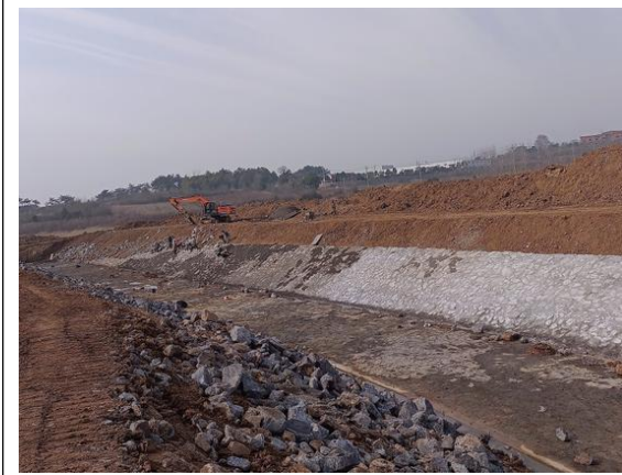
泵站进水渠浆砌石护砌临时苫盖 (2025.3.15)
