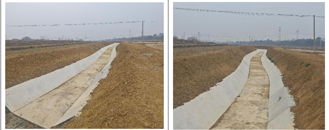
支渠整治完毕（2025.2.19）
