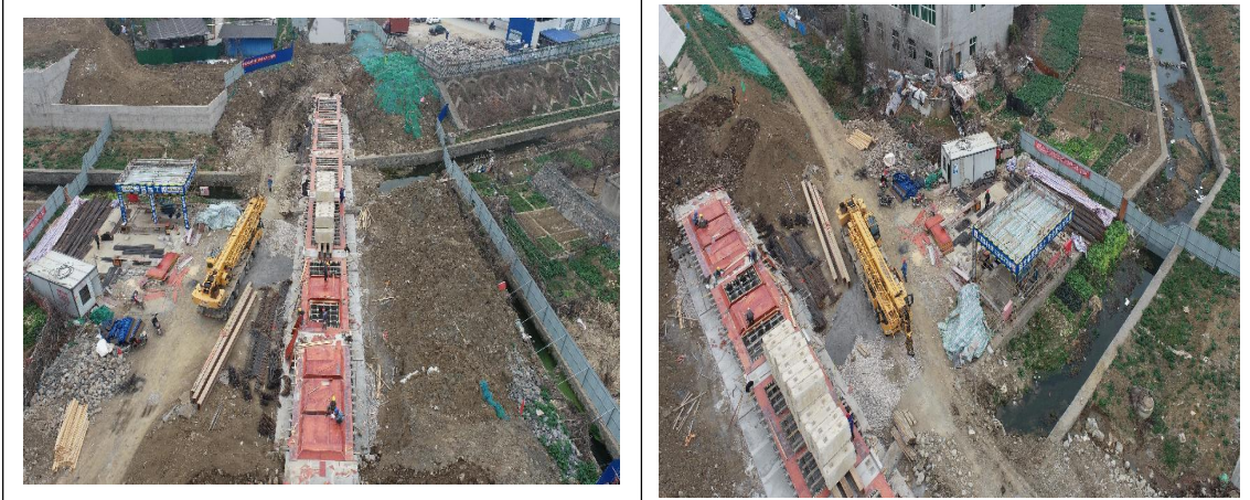
小张湾渡槽施工 (2025.2.19)
