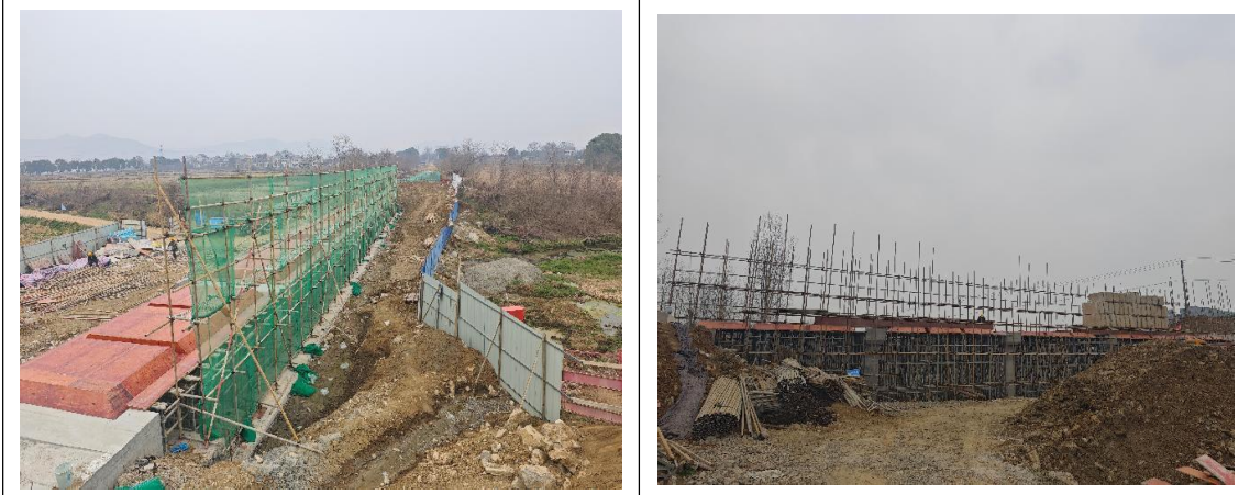
七里桥渡槽施工（2025.2.19）
