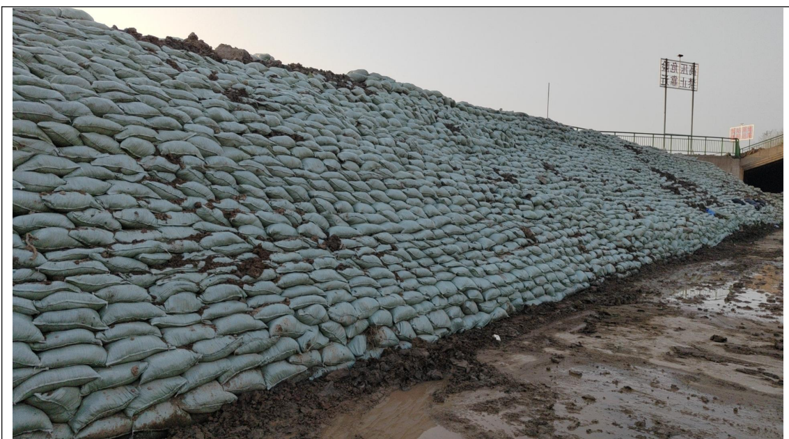
围堰填筑施工
