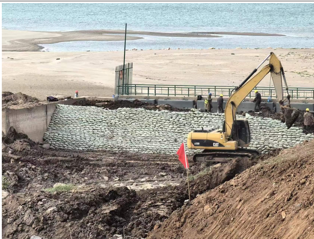
围堰填筑施工
