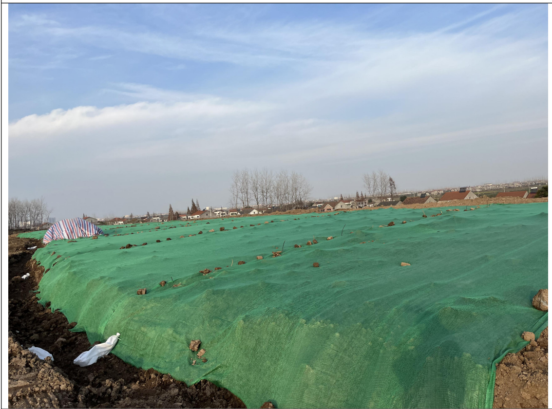
临时堆土苫盖及土质排水沟
