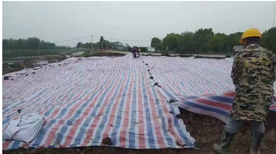
临时堆土苫盖
