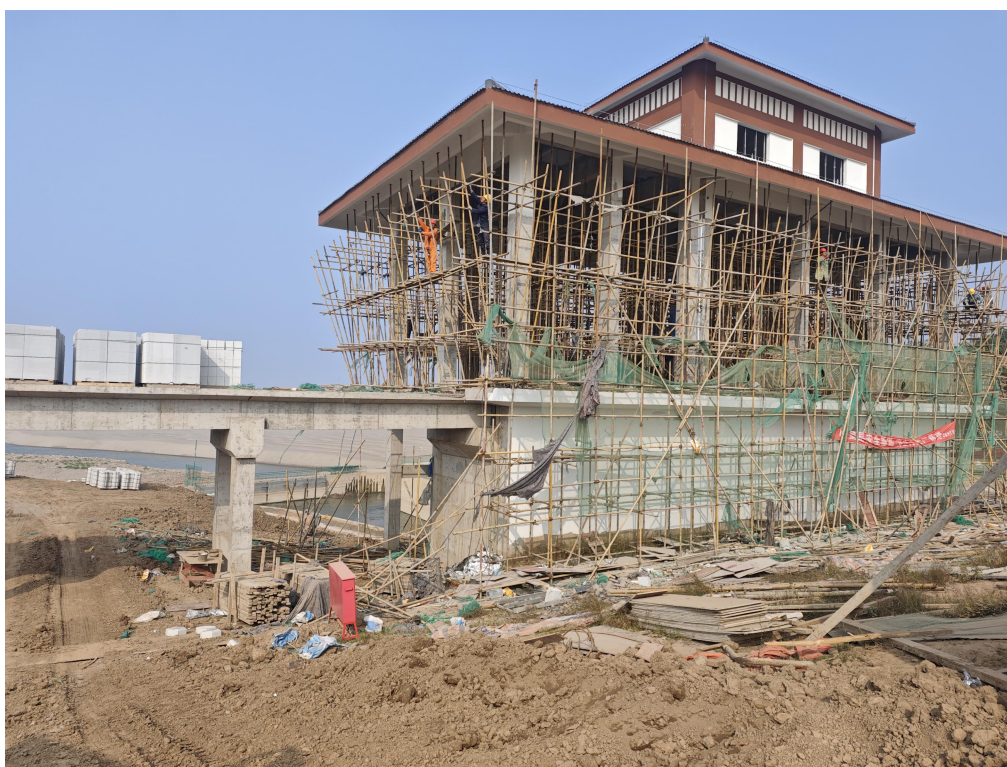
启闭机房屋顶浇筑完成
