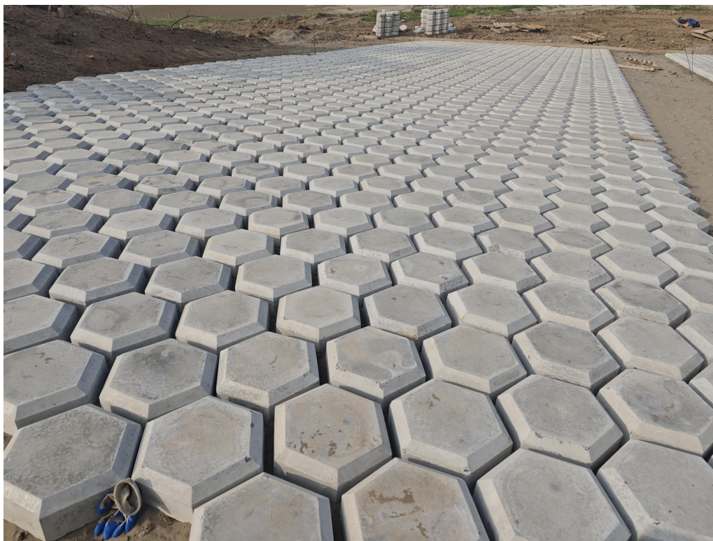
进口护坡六方块铺装
