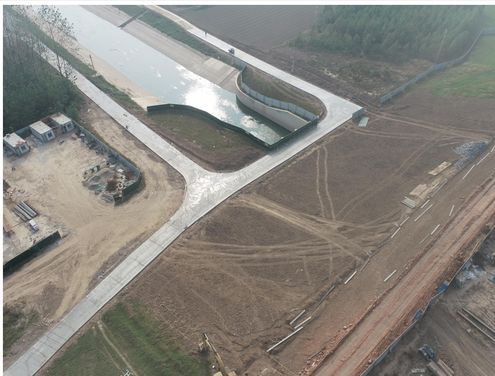
闸站工程区表土回覆
