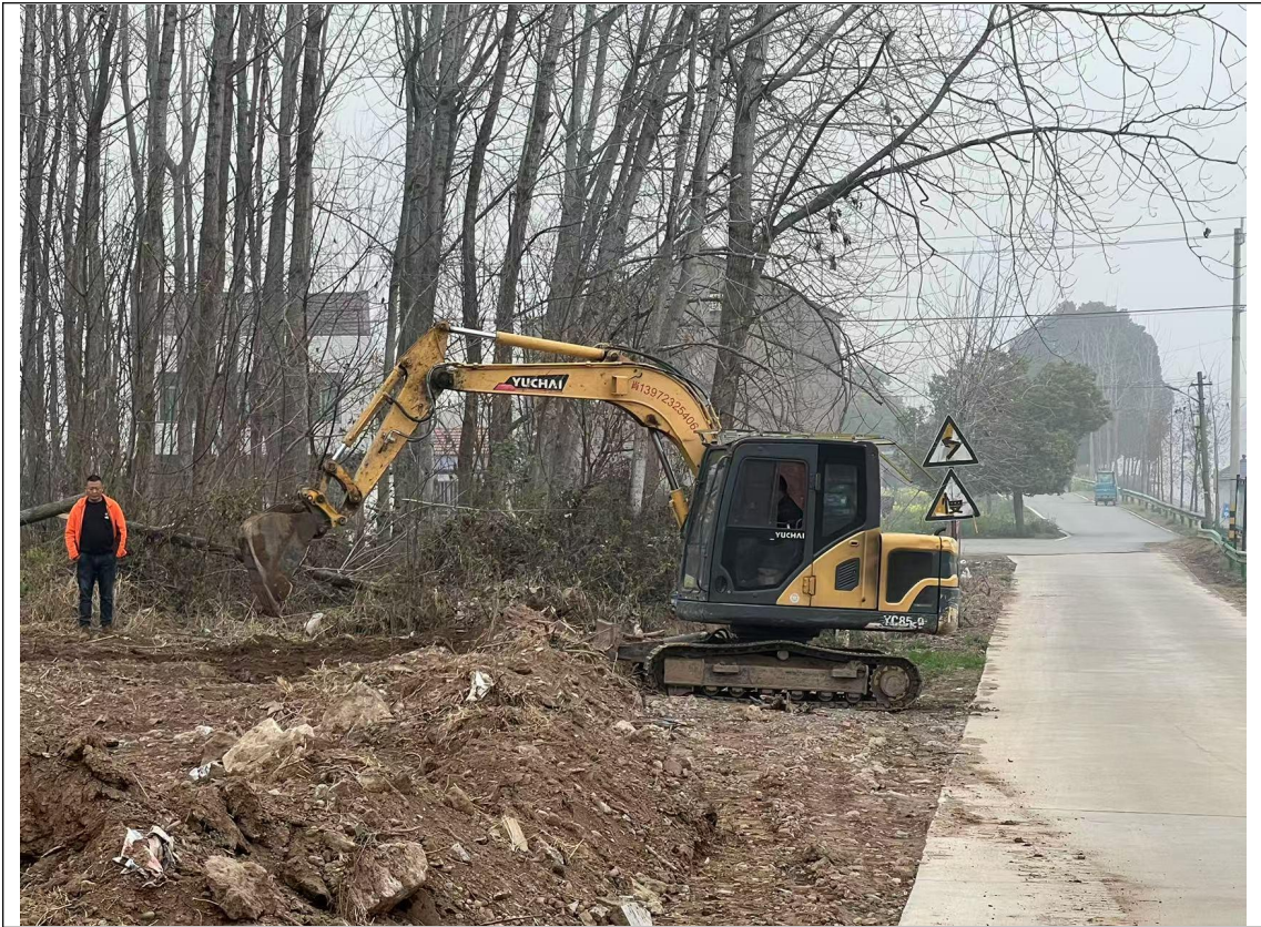
施工生产生活区硬化清除
