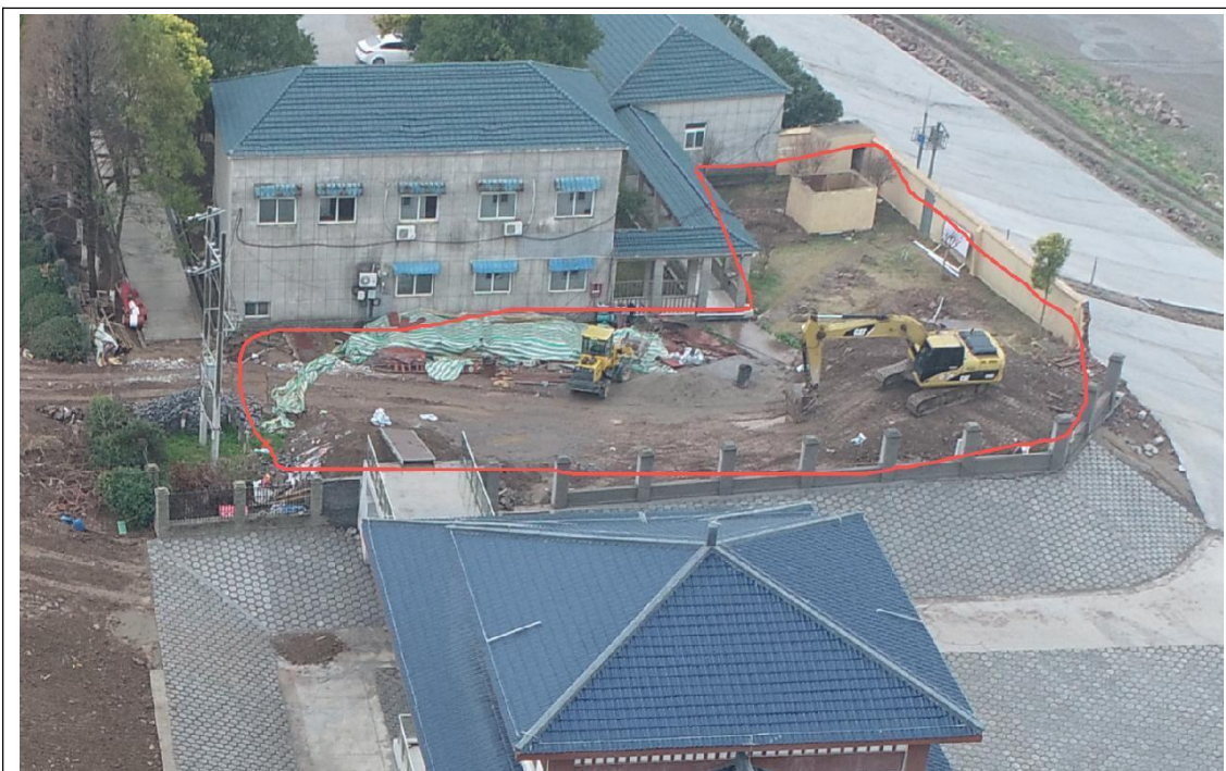
管理房建设区域
